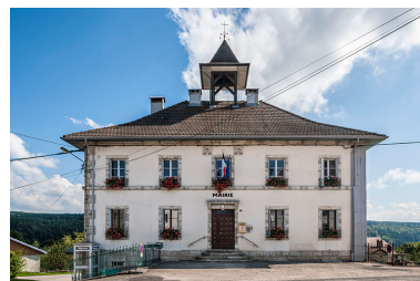
Façade antérieure. Phot. Jérôme Mongreville IVR43_20142501115NUC4A
