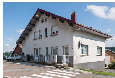
Nouvelle fromagerie (1963) vue de trois quarts droite. Phot. Jérôme Mongreville IVR43_20142501113NUC4A
