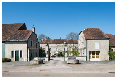
Vue générale. Phot. Jérôme Mongreville IVR43_20177000395NUC4A
