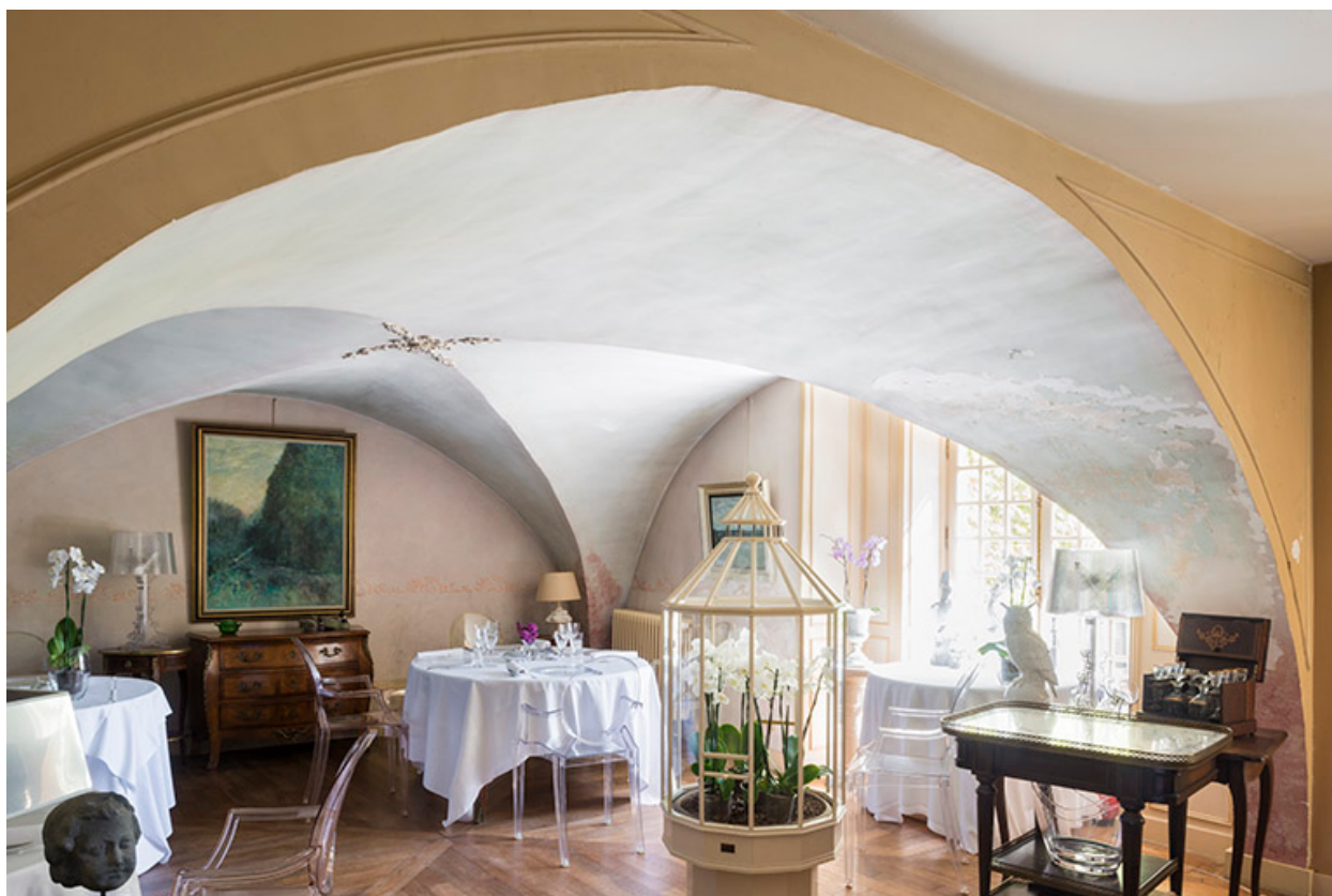
Vue sur les voûtes.
