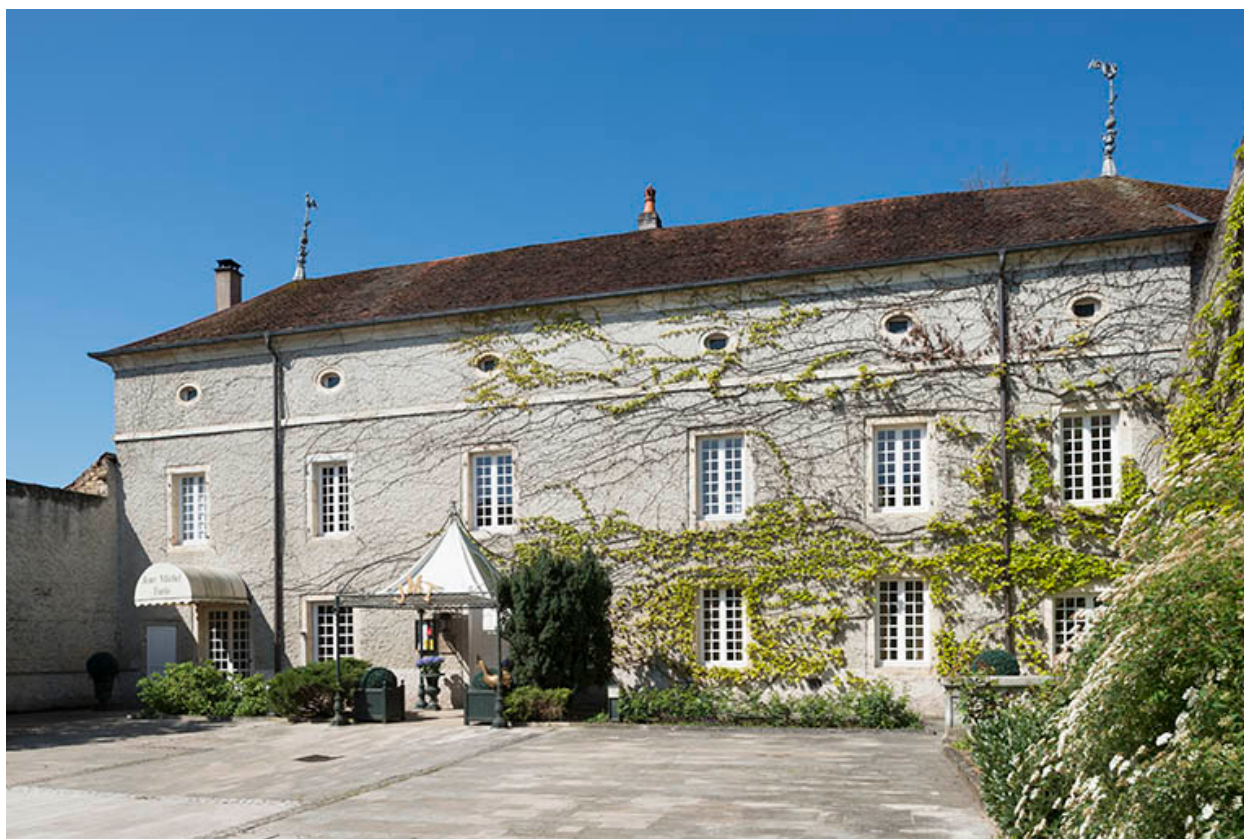
La façade principale.
