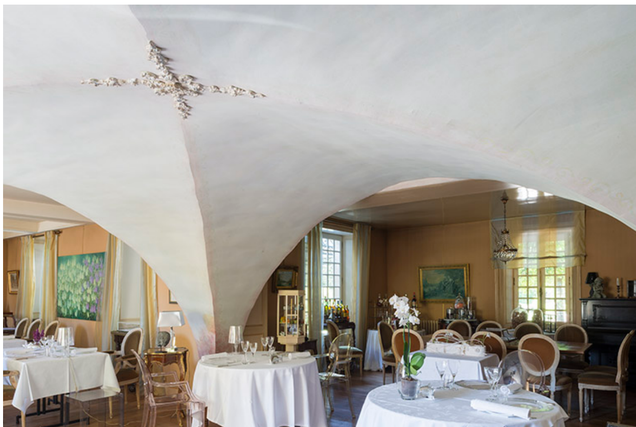
Détail au niveau de la croisée.
