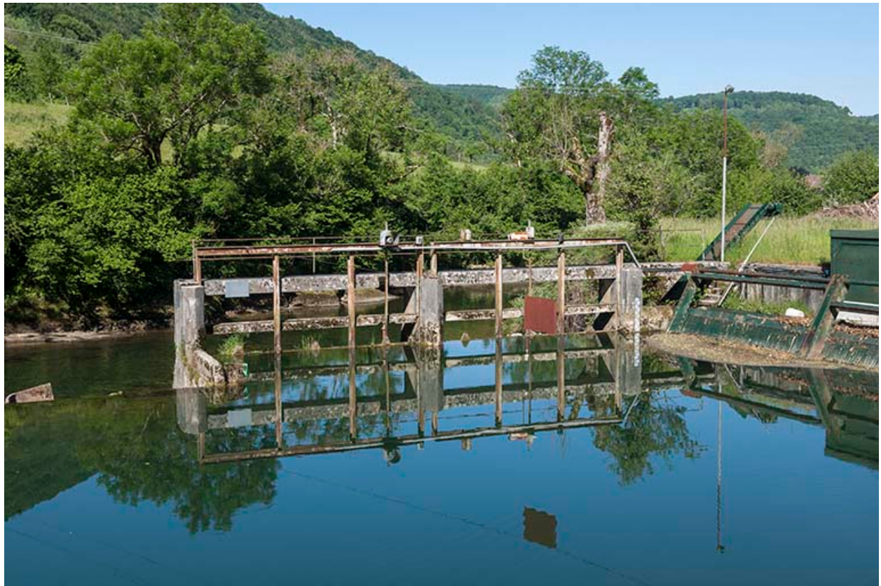
Vannage du barrage.
