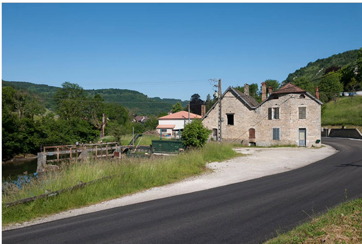
Vue d'ensemble depuis le sud.
