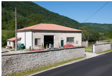
La centrale hydroélectrique. Phot. Jérôme Mongreville IVR43_20152501302NUC4A
