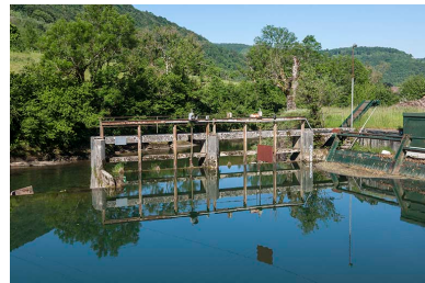
Vannage du barrage. Phot. Jérôme Mongreville IVR43_20152501305NUC4A
