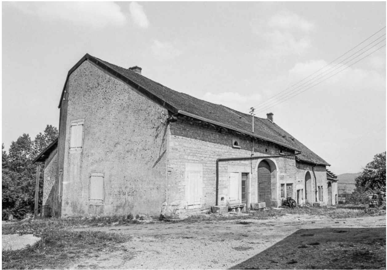
Ferme cadastrée D2 257, 259, 260 : vue d'ensemble.
