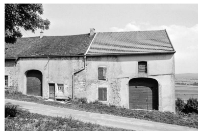
Fermes cadastrées section A : façades sur rue. Phot. Bernard Pontefract IVR43_19763900339Z
