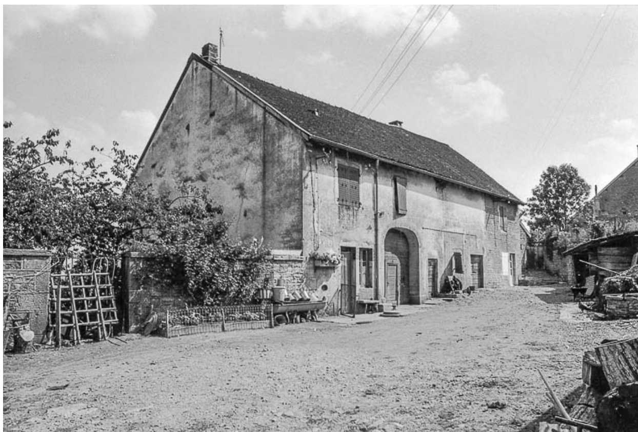
Ferme cadastrée D2 262 et 266 : façade antérieure.
