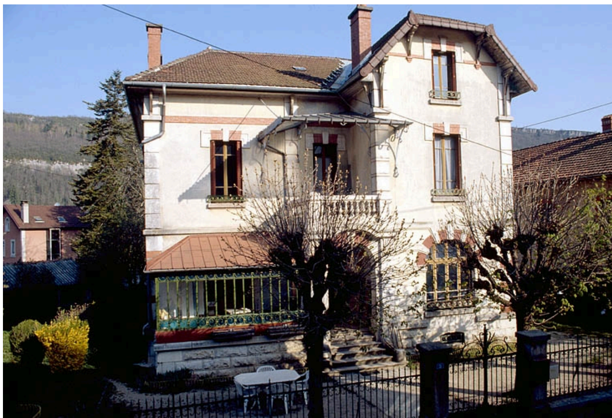
Maison d'industriel à Molinges : façade antérieure.
