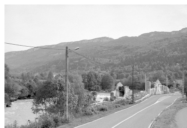
Usine de Molinges : vestiges. Phot. Laurent Poupard IVR43_19903900585Z
