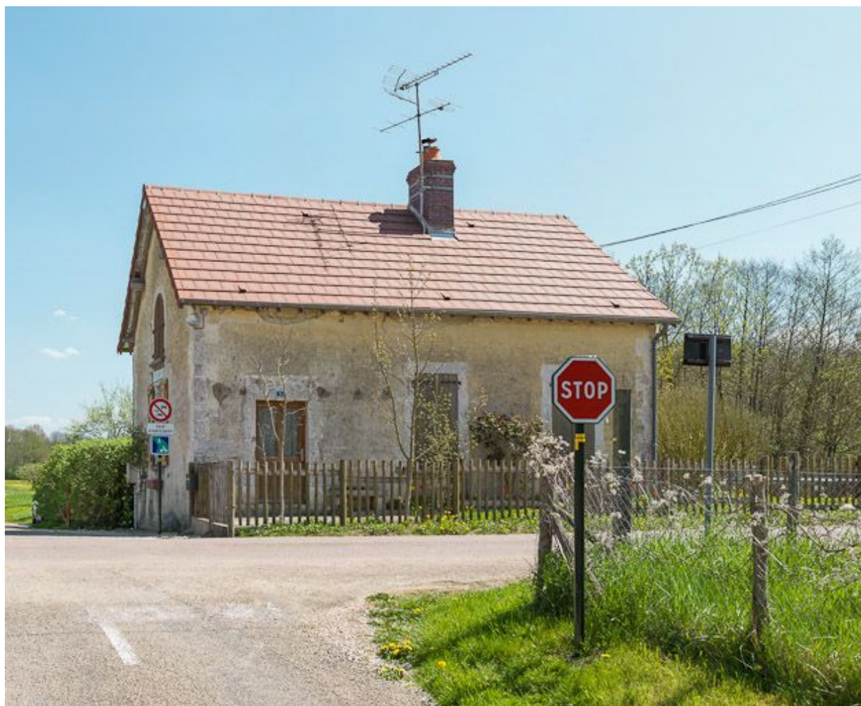
Maison éclusière, façade sur route.
