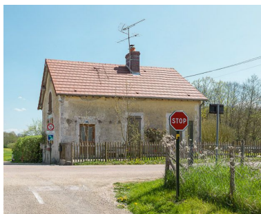
Maison éclusière, façade sur route.
