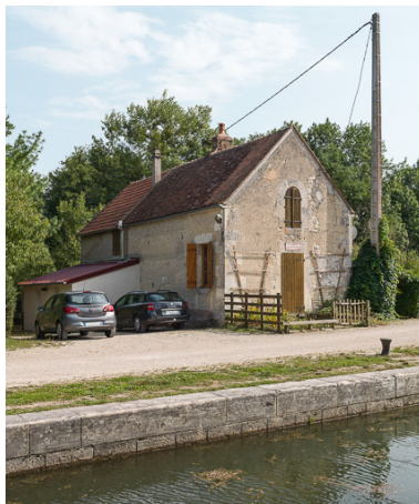
Vue de la maison éclusière.
