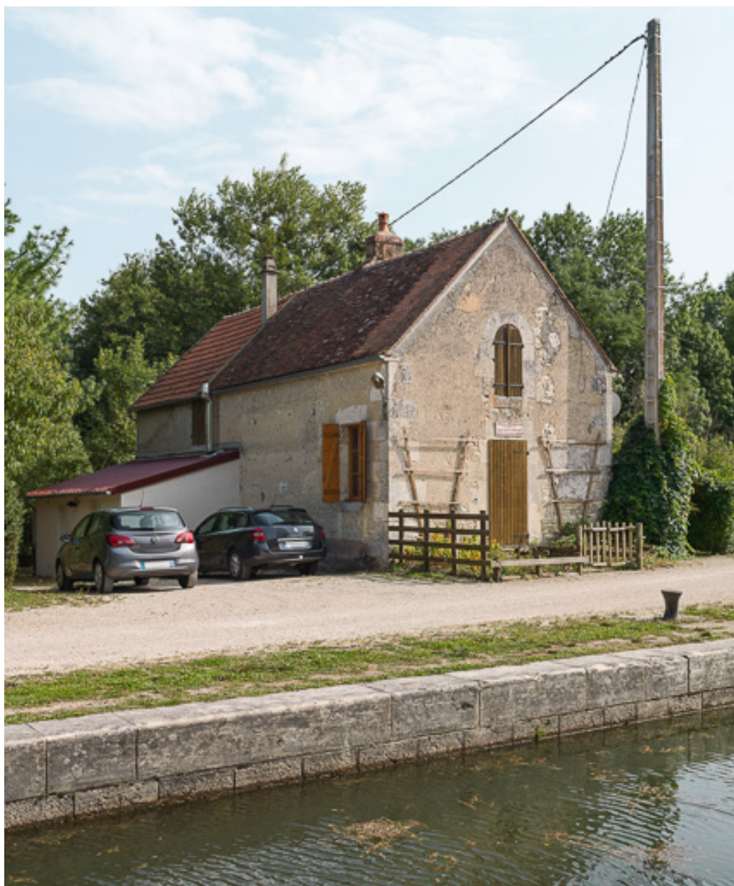
Vue de la maison éclusière.
