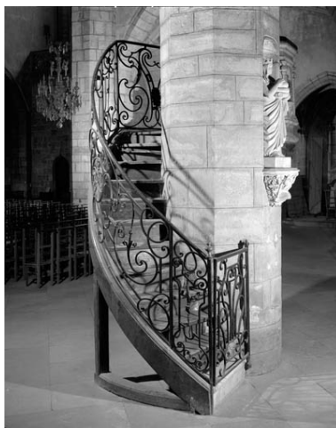
Vue d'ensemble de l'escalier en ferronnerie. Phot. Yves Sancey IVR43_19917000535V
