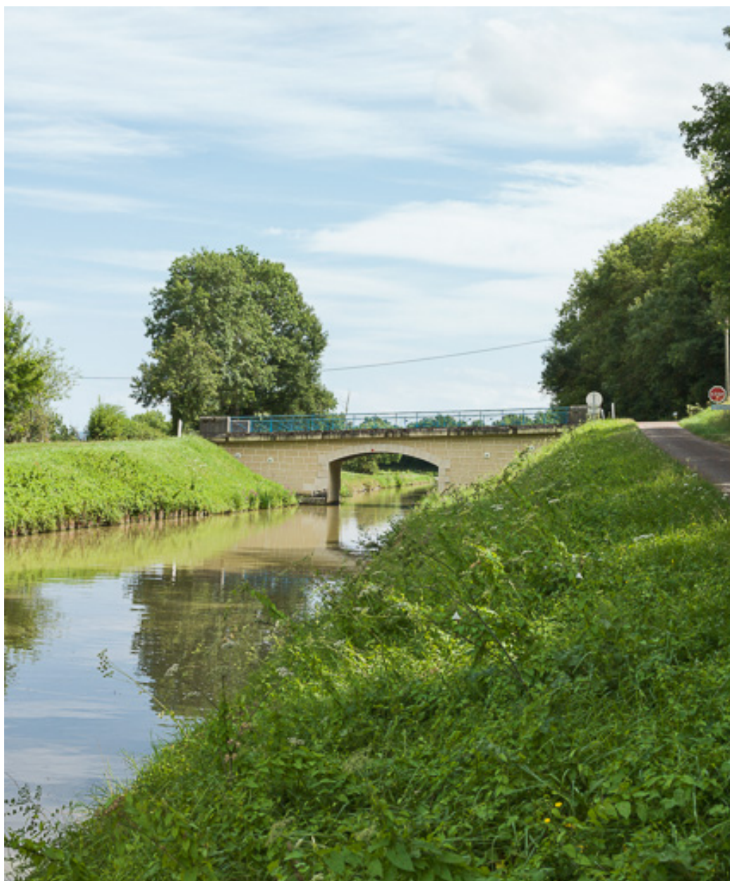
Vue d'ensemble du pont et du site.
