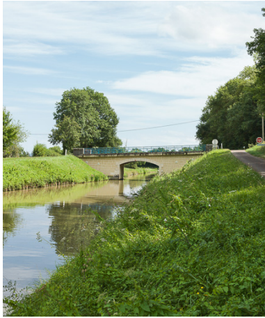
Vue d'ensemble du pont et du site. Phot. Pierre-Marie Barbe-Richaud IVR26_20175800160NUC2A
