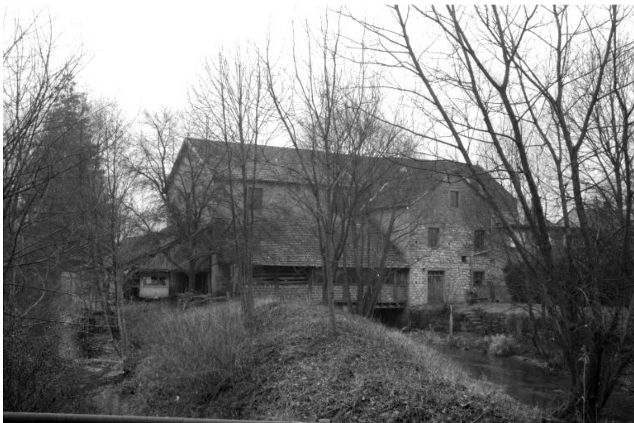
Façade postérieure de la minoterie.
