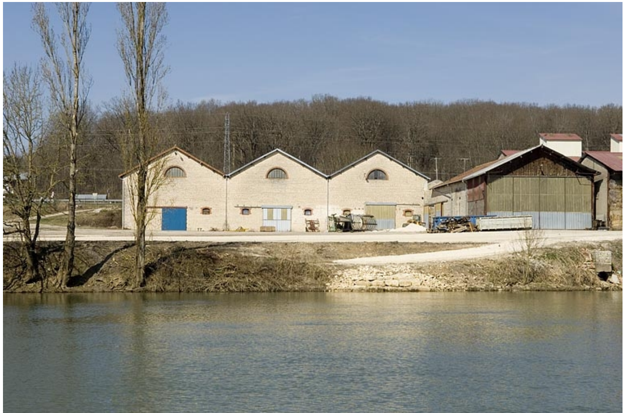
Atelier de fabrication depuis le sud-est.
