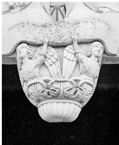
Extérieur : portail, façade antérieure, détail. Phot. Yves Sancey IVR43_19767000558X
