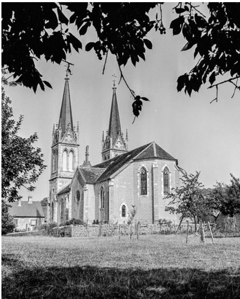
Extérieur : façades postérieure et latérale droite.
