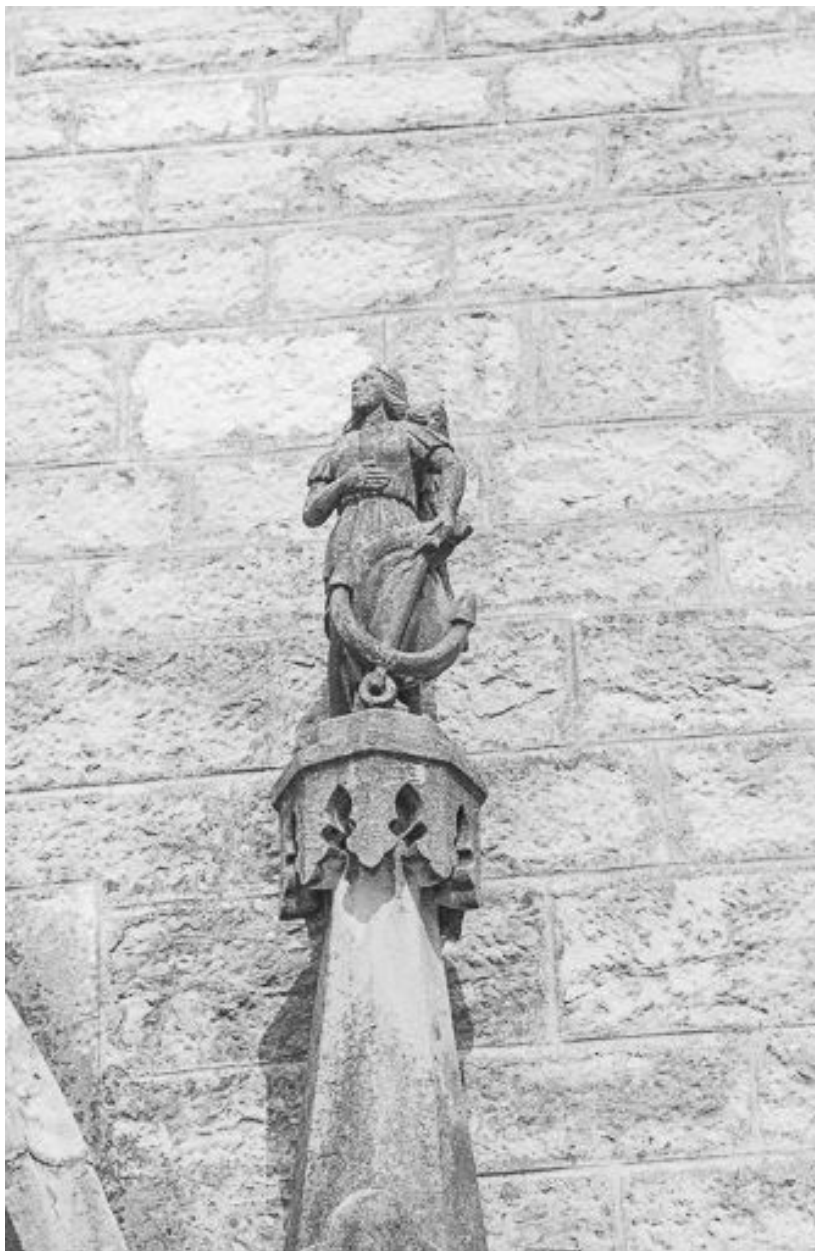
Extérieur : portail, façade antérieure, détail.
