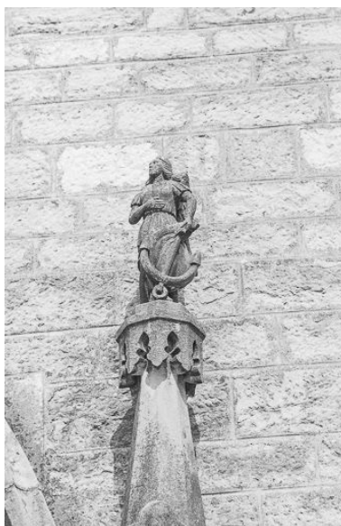
Extérieur : portail, façade antérieure, détail. Phot. Yves Sancey IVR43_19767000556Z
