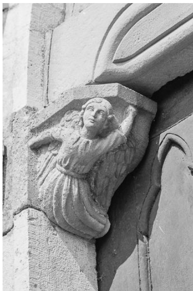
Extérieur : portail, façade antérieure, détail. Phot. Yves Sancey IVR43_19767000559Z
