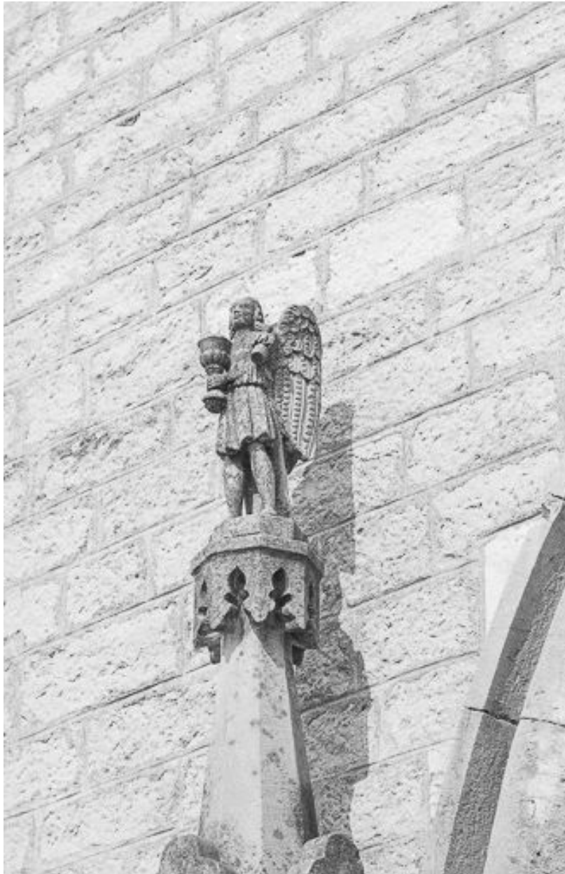
Extérieur : portail, façade antérieure, détail.
