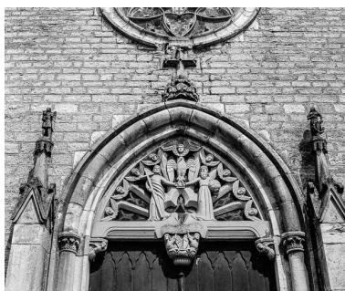
Extérieur : portail, façade antérieure, détail. Phot. Yves Sancey IVR43_19767000554X
