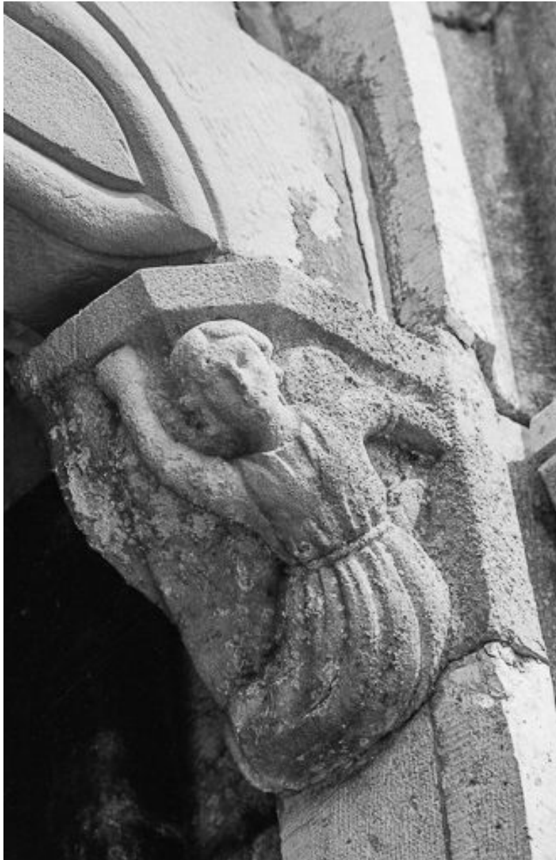
Extérieur : portail, façade antérieure, détail.
