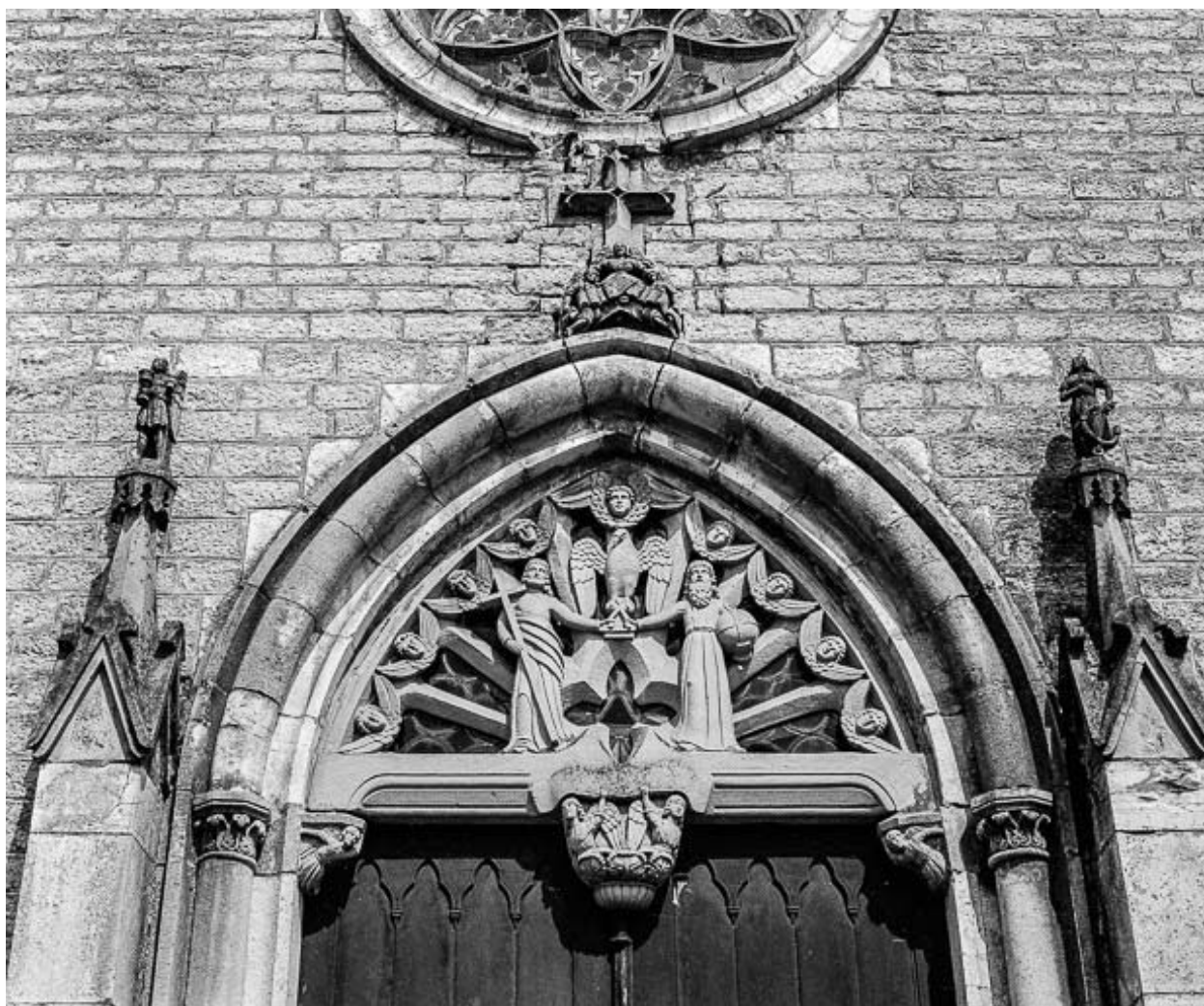
Extérieur : portail, façade antérieure, détail.
