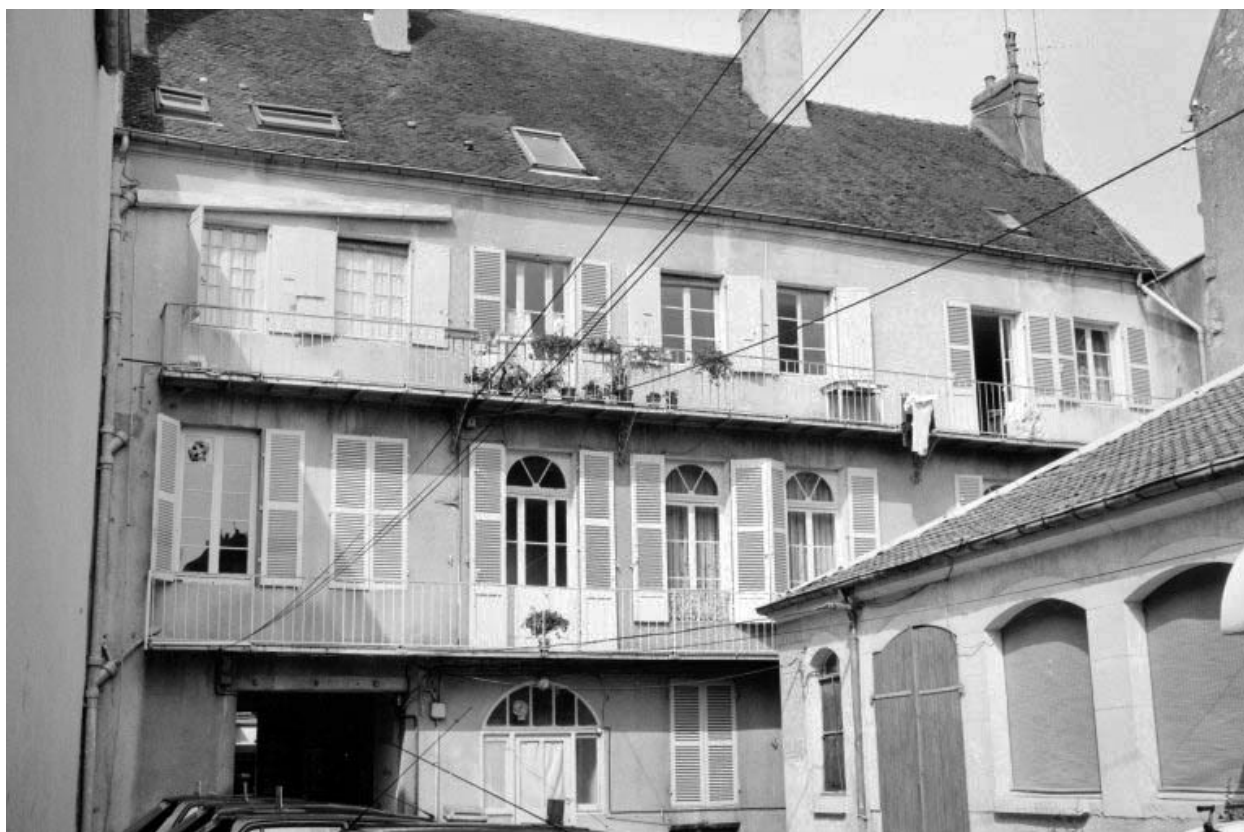
Façade postérieure de la maison.
