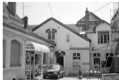
Façade antérieure du bureau. Phot. Laurent Poupard IVR43_19893900099Z
