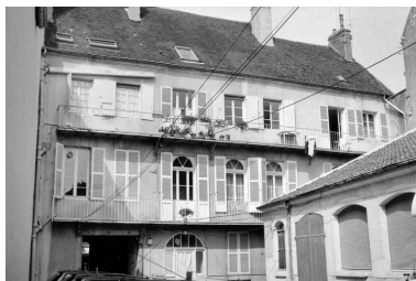
Façade postérieure de la maison. Phot. Laurent Poupard IVR43_19893900098Z
