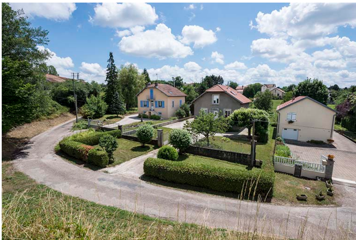
Pavillons construits en contre-bas de la gare.
