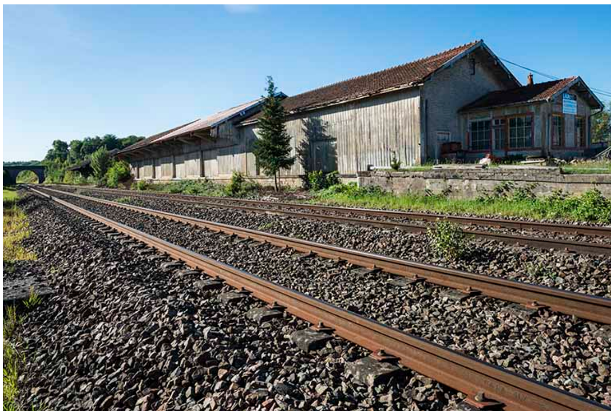
L'entrepôt de l'ancienne gare de Port-sur-Saône.
