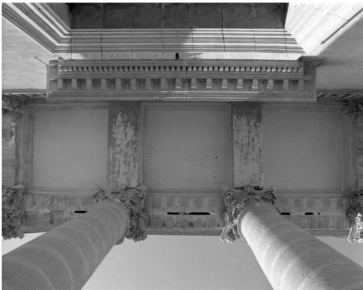
Façade antérieure : plafond de l'avant-corps central.
