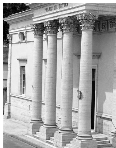
Façade antérieure : avant- corps central, détail des colonnes corinthiennes. Phot. Yves Sancey IVR43_19897000460X
