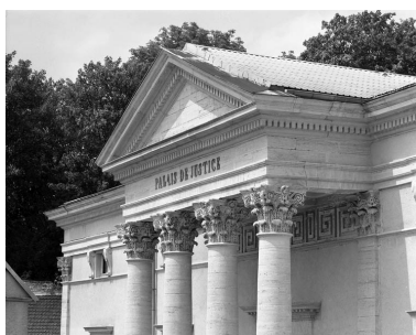
Façade antérieure : avant- corps central, détail du fronton. Phot. Yves Sancey IVR43_19897000461X
