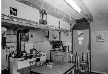
Cuisine : poutre supportant la cheminée. Phot. Gilbert Poinot IVR43_19752501204Z
