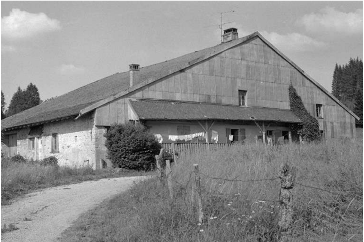
Façades antérieure et latérale gauche.
