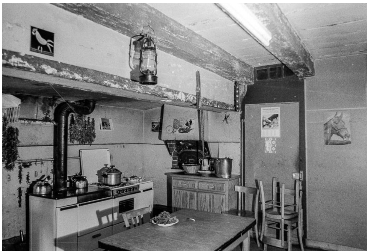
Cuisine : poutre supportant la cheminée.
