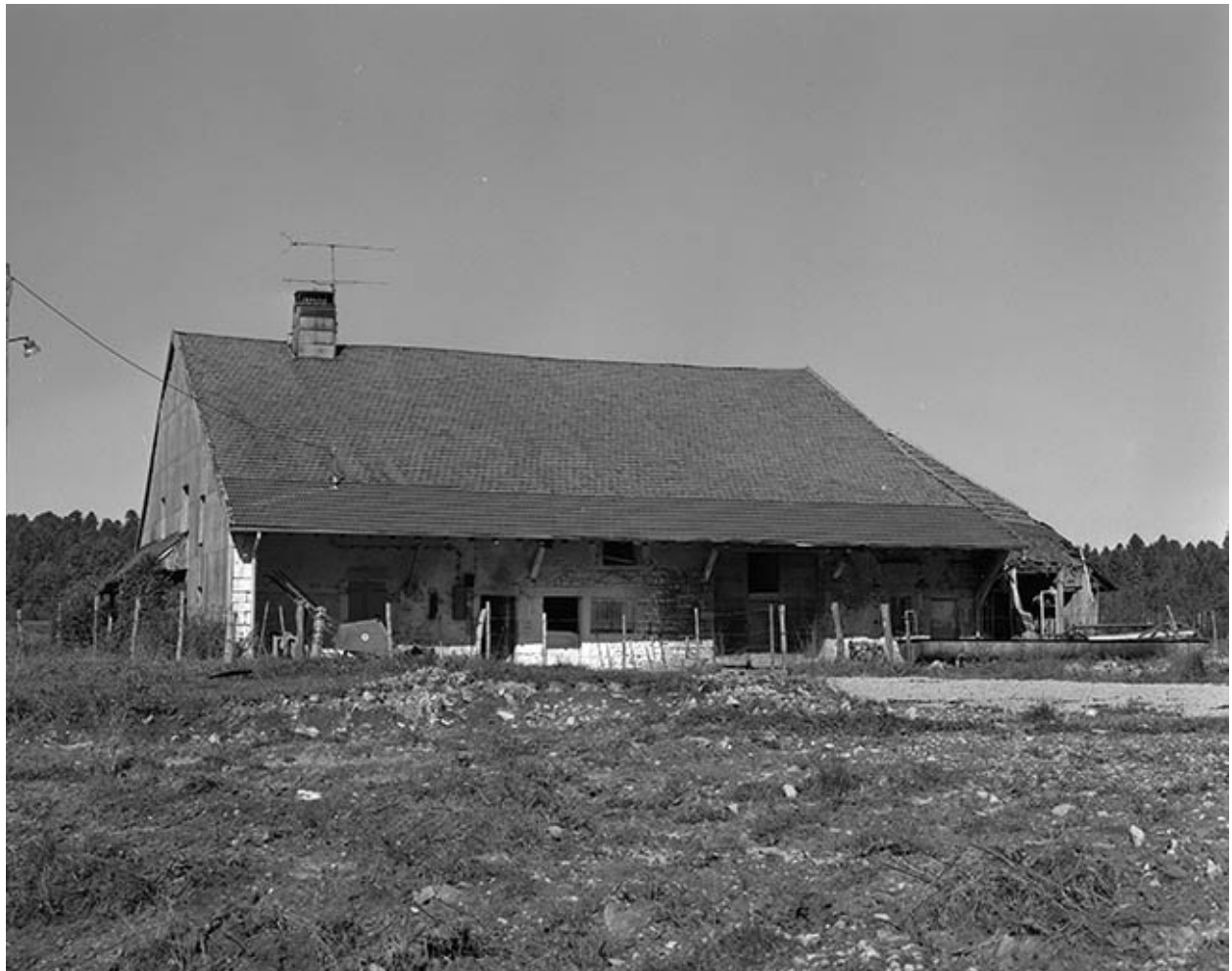
Façade latérale droite.
