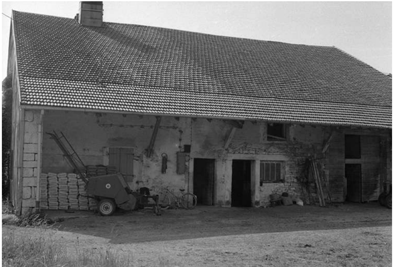
Façade latérale droite.
