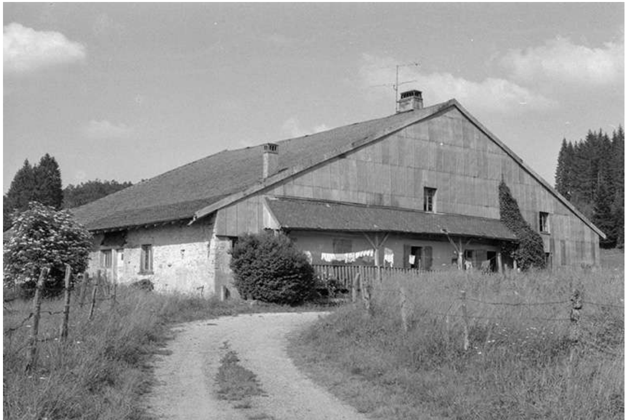
Façades antérieure et latérale gauche.
