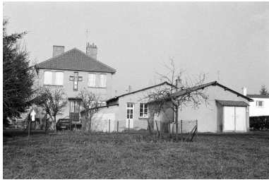
Façade Sud-Est du Presbytère. Phot. Frédéric Pillet IVR26_19997100068Z
