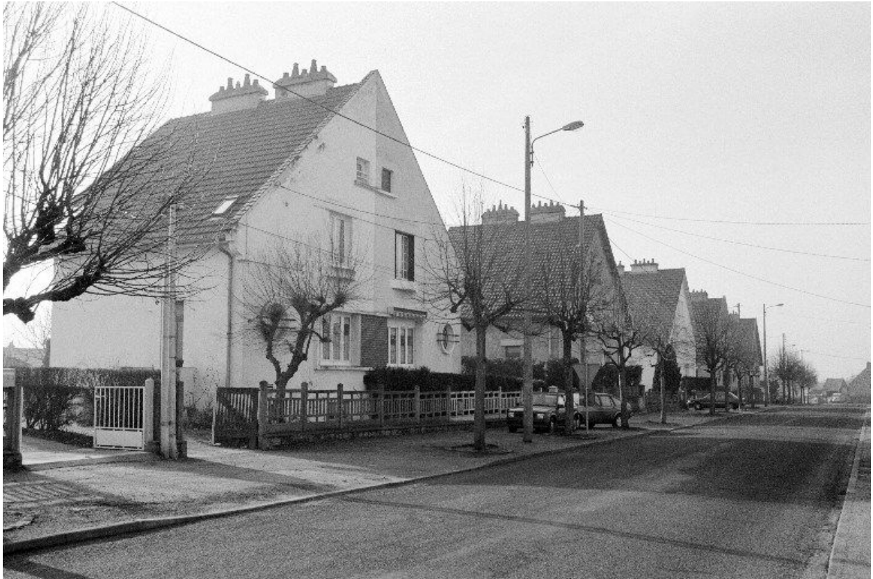
Bâtiments à 2 logements ouvriers de " type 16 " au 65-67 rue Jean Didier.
