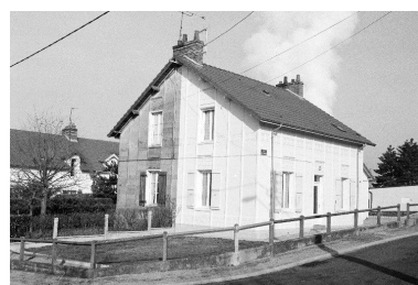
Bâtiment à 2 logements ouvriers de " type 3 " dit " murs minces " au 20 rue des Goujons.
