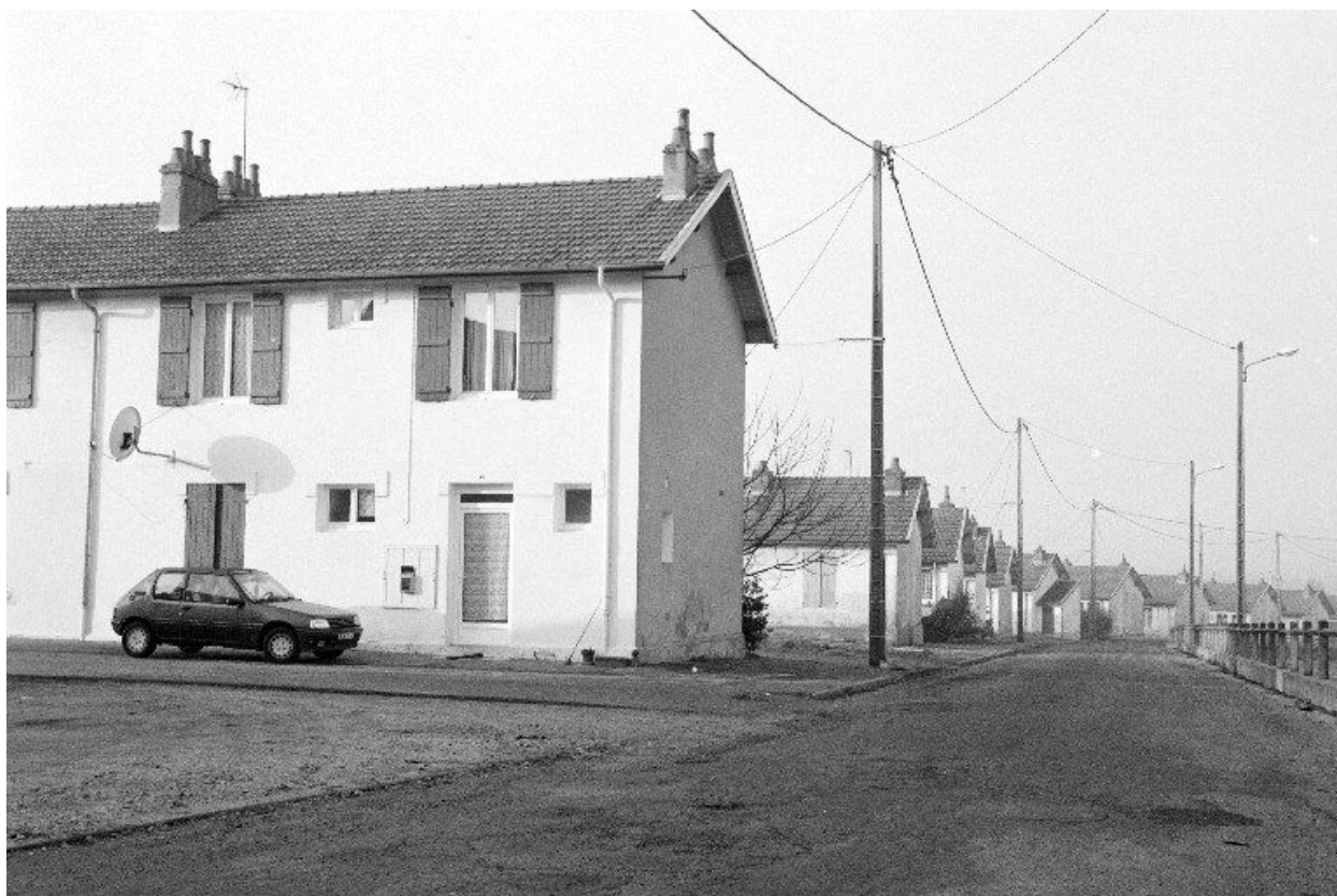
Bâtiments à 3 et 4 logements ouvriers ou "baraquements".
