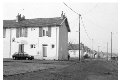
Bâtiments à 3 et 4 logements ouvriers ou "baraquements".
