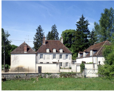
Vue générale en 1990. Phot. Yves Sancey IVR43_19903901209XA
