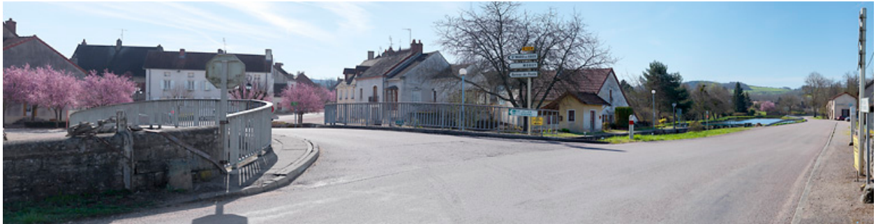
Vue d'ensemble du site d'écluse 17 avec le pont.
