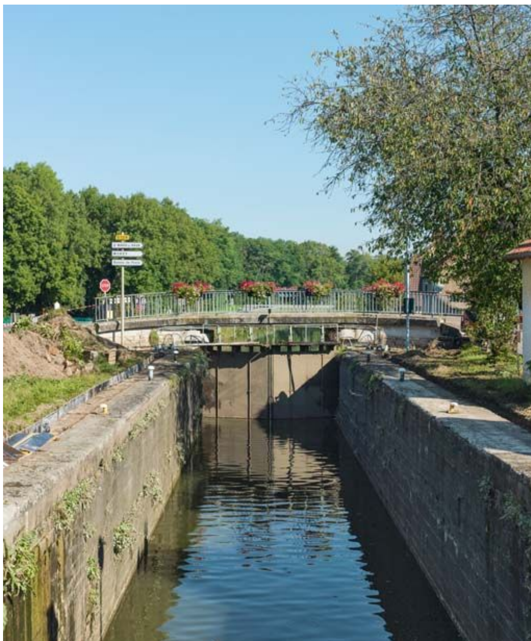
Vue d'ensemble du pont.
