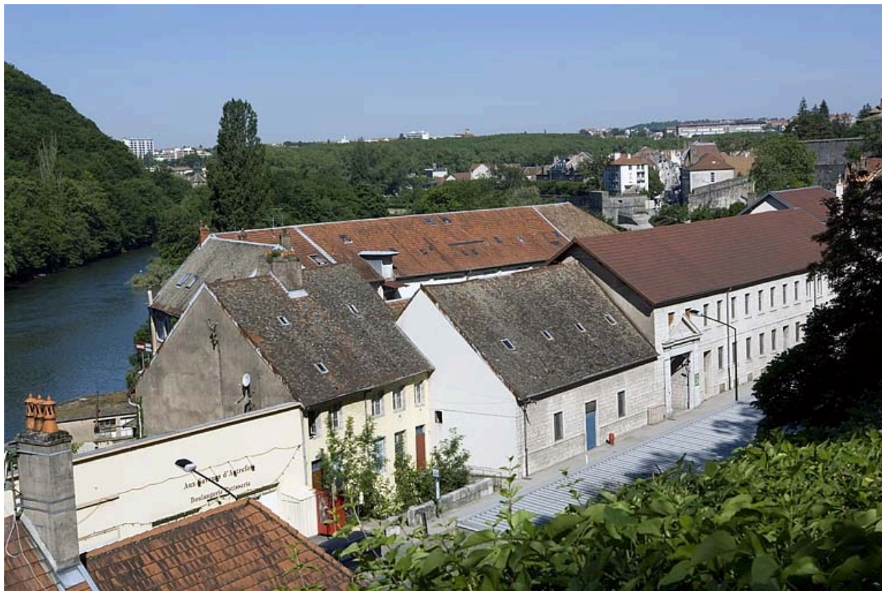
Façade antérieure des bâtiments sur rue, depuis le sud-est.
