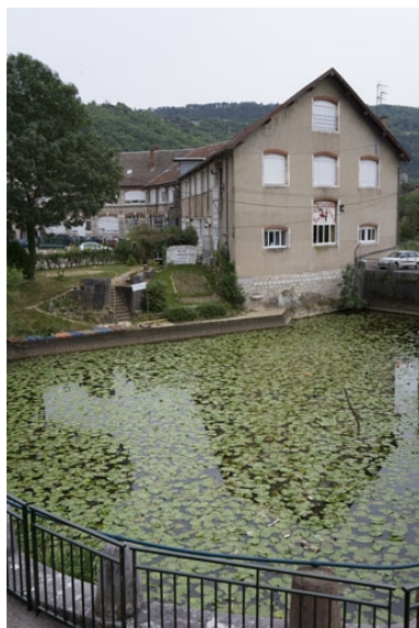
Façade latérale droite (amont) des ateliers de fabrication, de trois quarts gauche. Phot. Yves Sancey IVR43_20062500282NUCA
