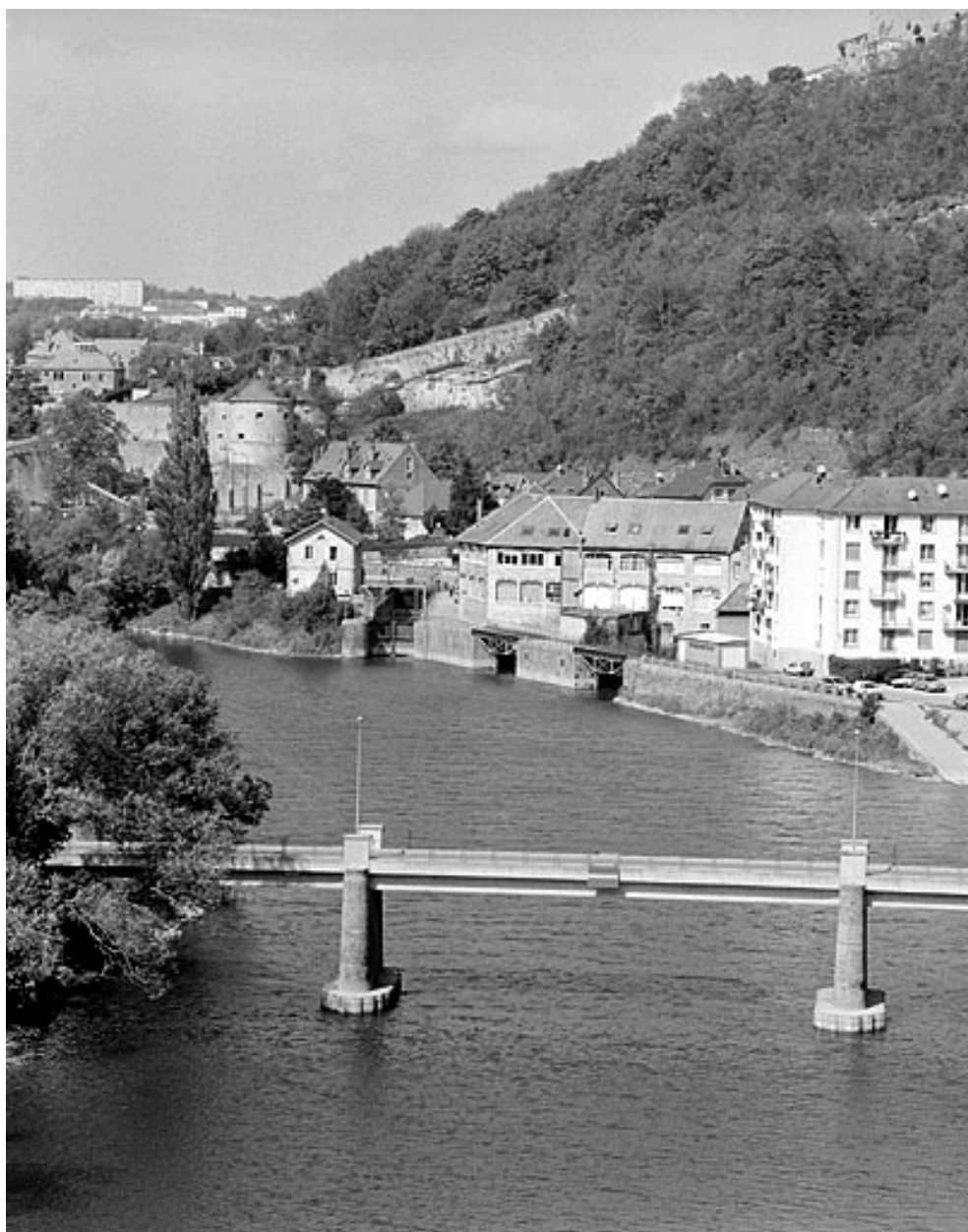
Vue d'ensemble plongeante, depuis l'aval.
