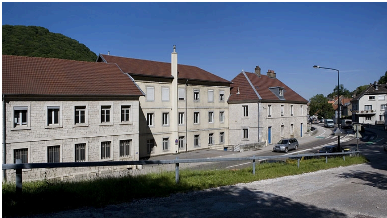
Façade antérieure des bâtiments sur rue, depuis l'est.
