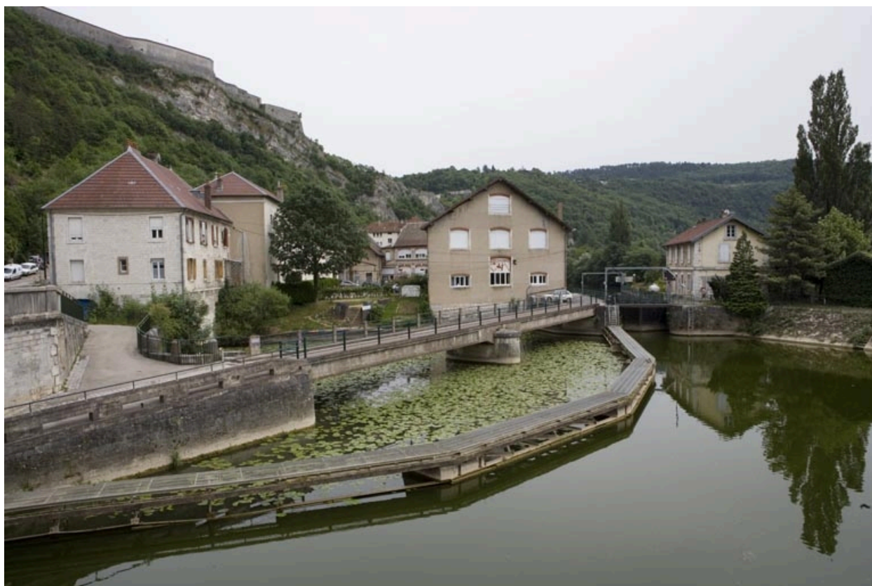
Façades amont (au nord-ouest).
