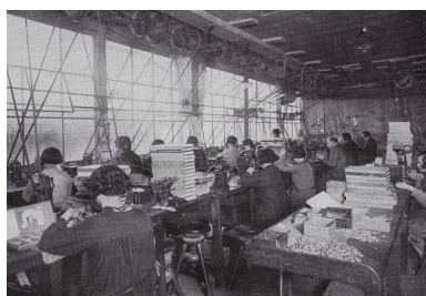
Geismar. - Fabrication de l'ébauche. - Atelier des perceuses, 1933. Phot. Yves Sancey IVR43_20062500273NUCA
