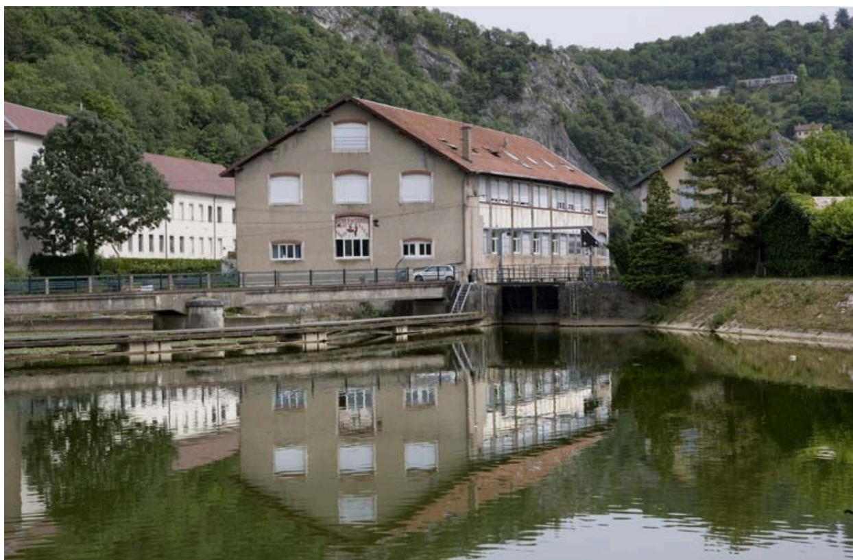
Façade latérale droite (amont) des ateliers de fabrication, de trois quarts droite.
