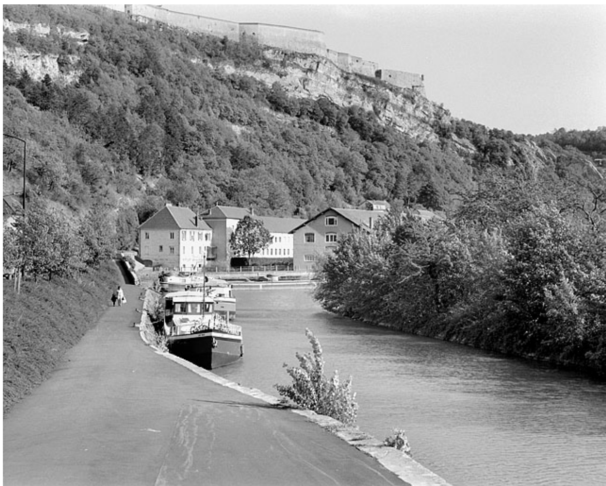
Vue d'ensemble, depuis l'amont.
