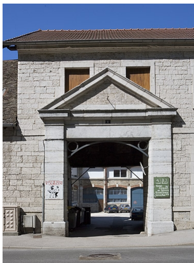
Porte cochère. Phot. Yves Sancey IVR43_20062500217NUCA
