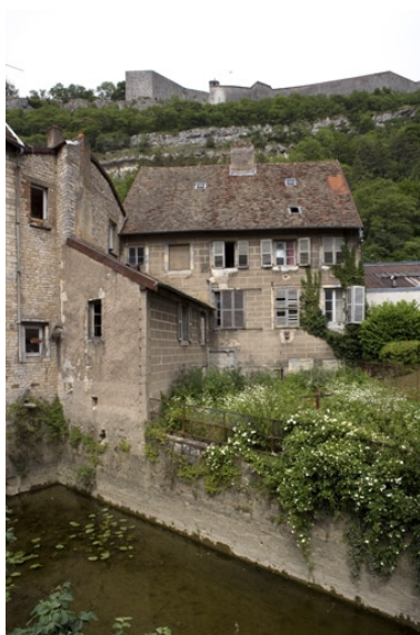
Façade postérieure des logements désaffectés. Phot. Yves Sancey IVR43_20062500295NUCA
