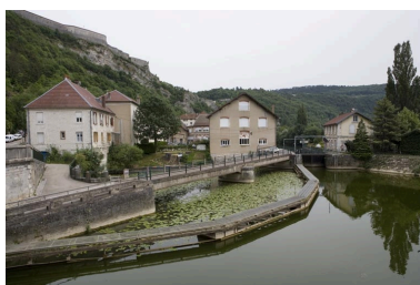
Façades amont (au nord-ouest). Phot. Yves Sancey IVR43_20062500280NUCA
