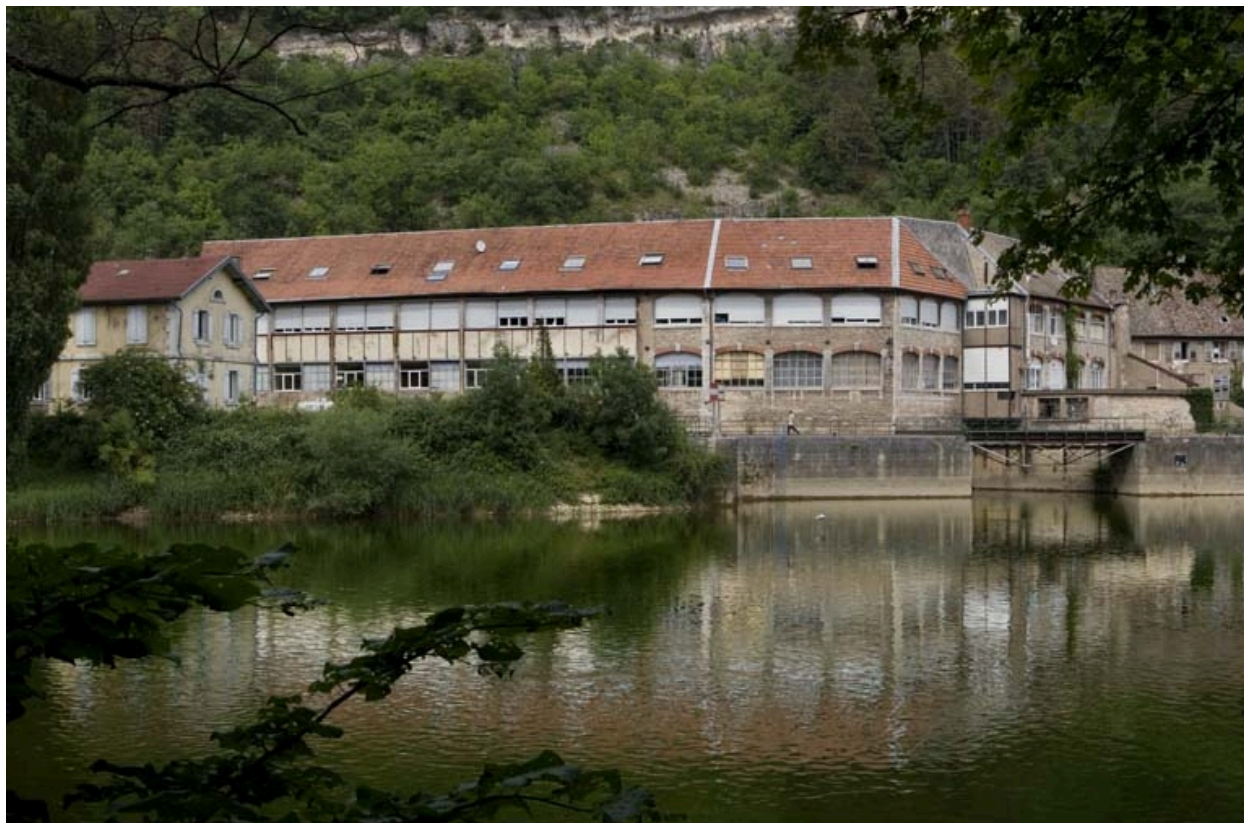
Vue d'ensemble de la façade sur rivière (postérieure) des ateliers de fabrication.
