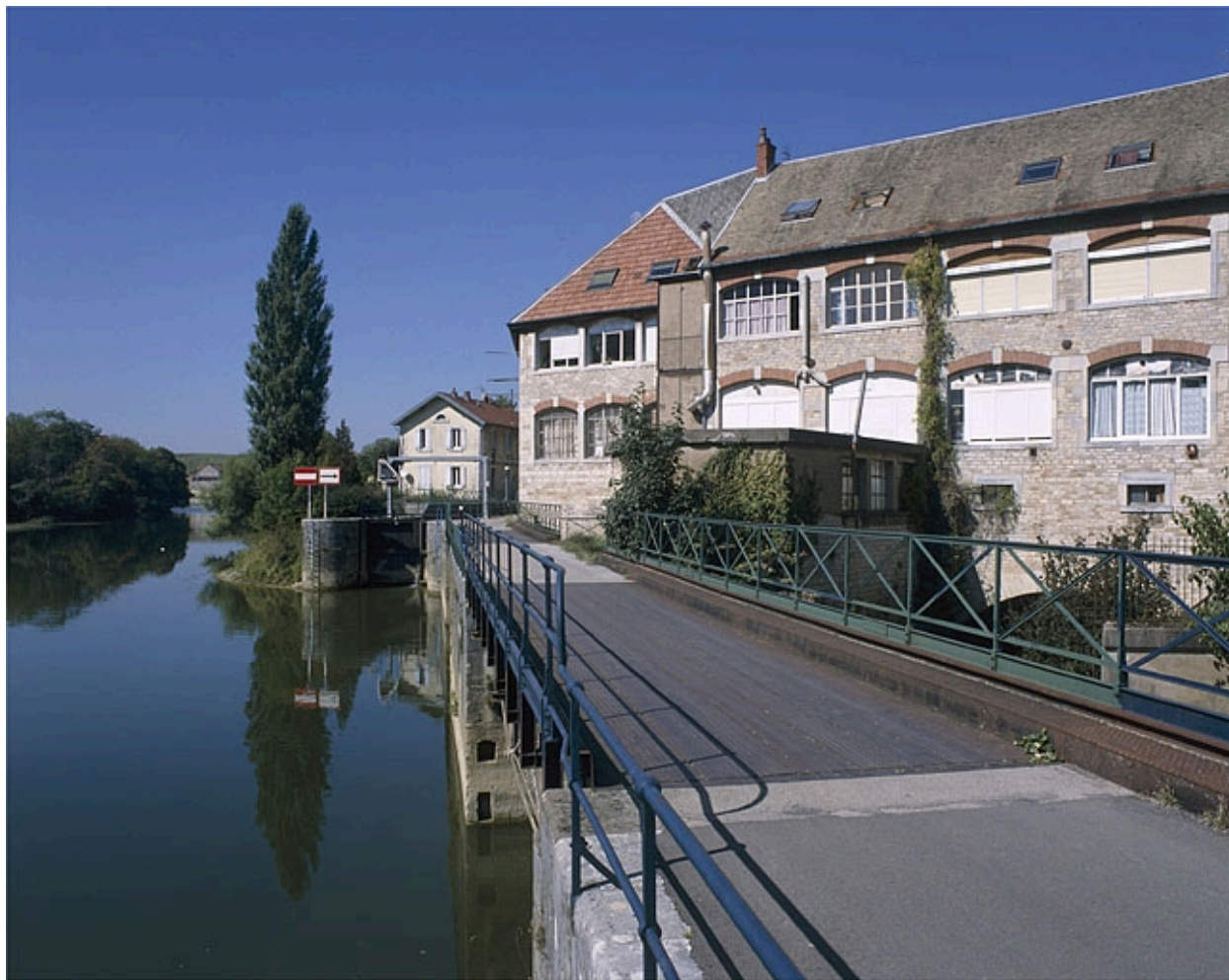
Pont de halage, depuis le chemin de halage.
