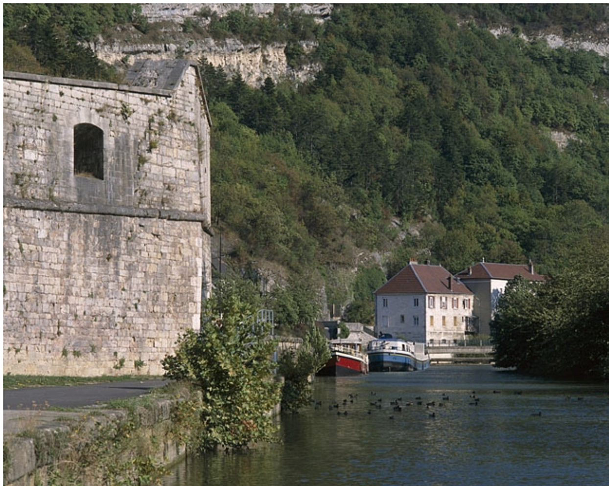
Vue d'ensemble, depuis l'amont.
