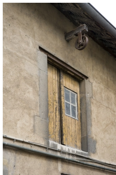
Fenêtre haute de la remise (côté cour), surmontée d'une poulie. Phot. Yves Sancey IVR43_20062500291NUCA
