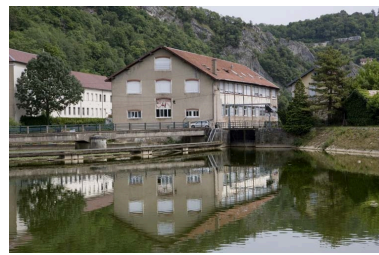
Façade latérale droite (amont) des ateliers de fabrication, de trois quarts droite. Phot. Yves Sancey IVR43_20062500279NUCA
