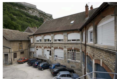
Façade antérieure des ateliers de fabrication, de trois quarts droite. Phot. Yves Sancey IVR43_20062500289NUCA
