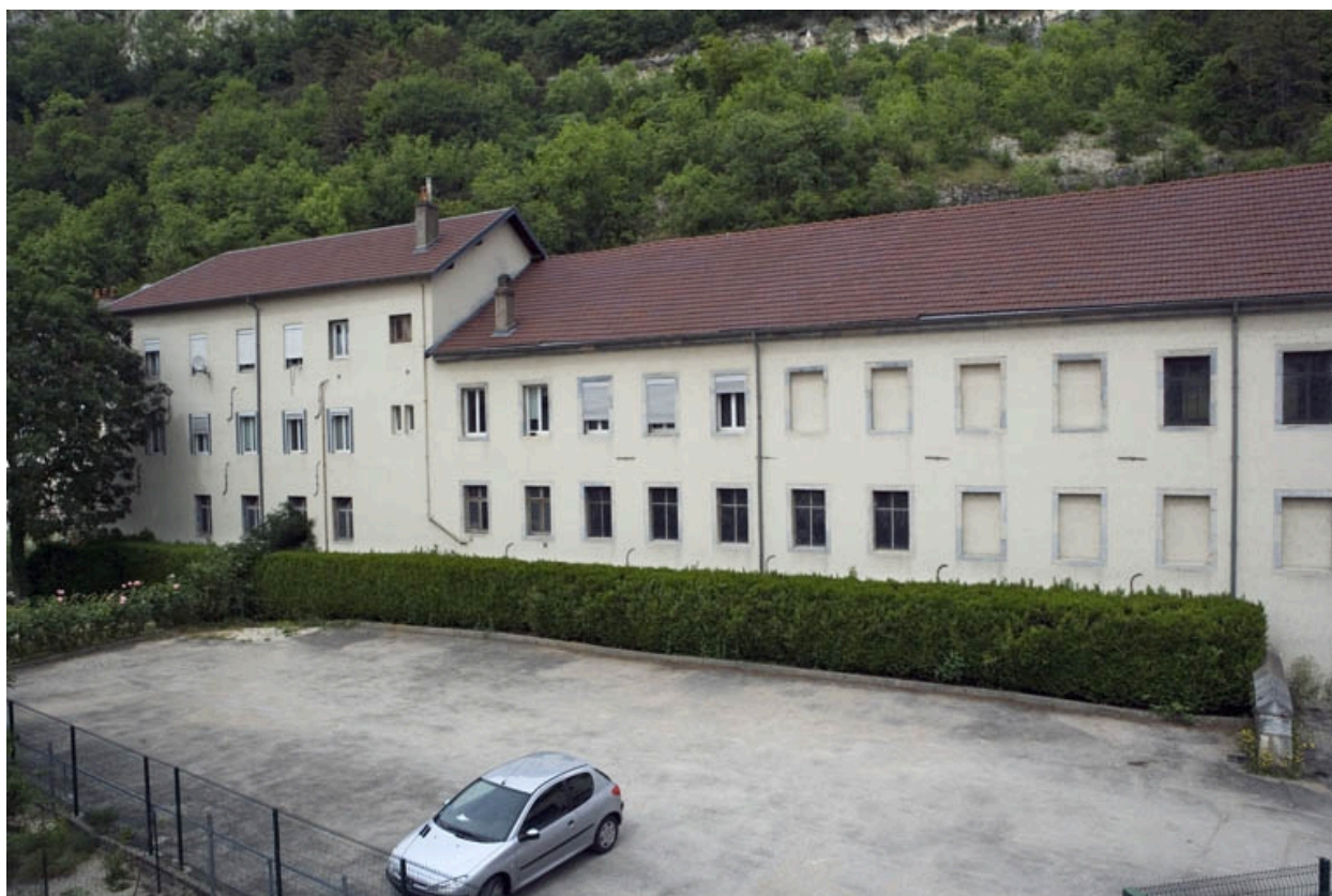
Façade postérieure du bâtiment d'eau et de l'ancien moulin, de trois quarts droite.
