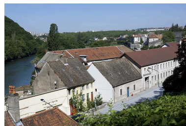
Façade antérieure des bâtiments sur rue, depuis le sud-est. Phot. Yves Sancey IVR43_20062500209NUCA
