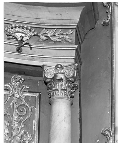
Chapiteau et entablement. Phot. Yves Sancey IVR43_19732500081X
