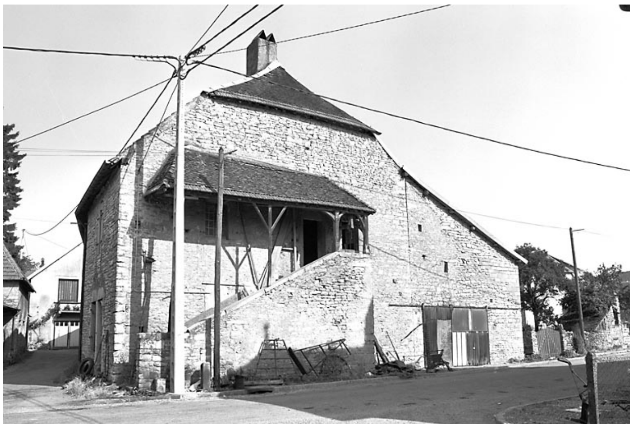
Façade avec l'escalier.
