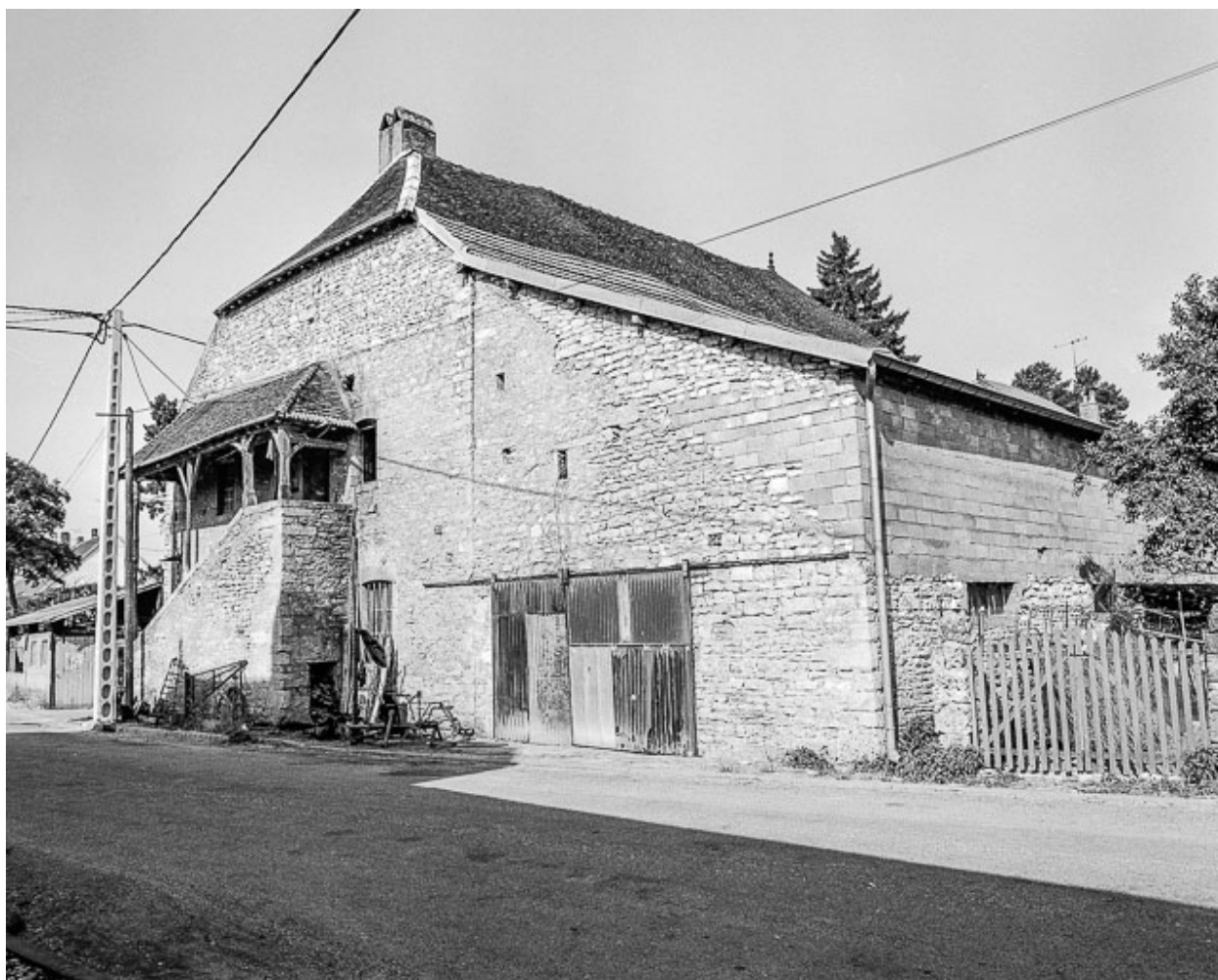
Façade avec escalier et dépendances.
