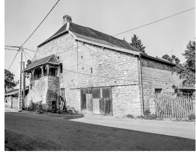
Façade avec escalier et dépendances. Phot. Bernard Lardière IVR43_19767000442X
