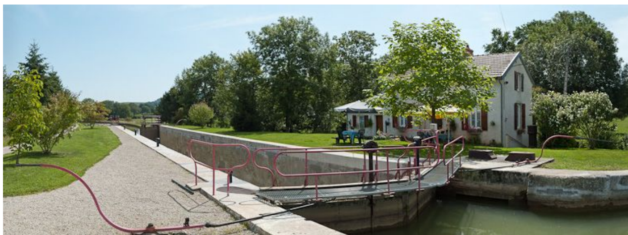
Vue d'ensemble du site d'écluse.
