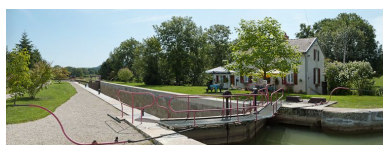
Vue d'ensemble du site d'écluse.
