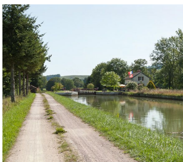
Vue du site d'écluse en amont.
