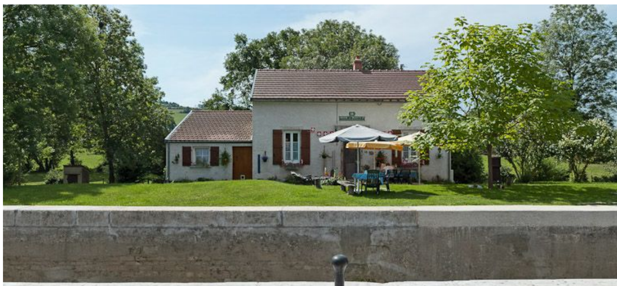
Vue de face de la maison éclusière.
