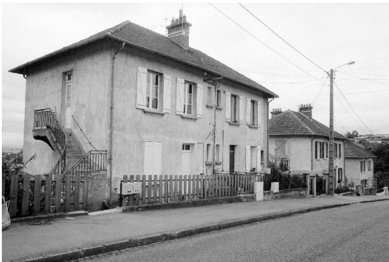
Bâtiments à quatre logements ouvriers de trois pièces, façades antérieures.
