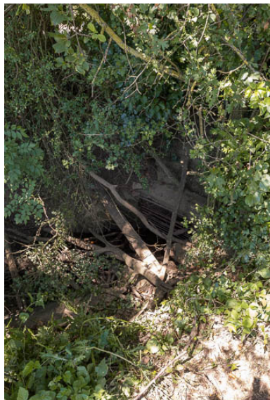
Vue de l'aqueduc.
