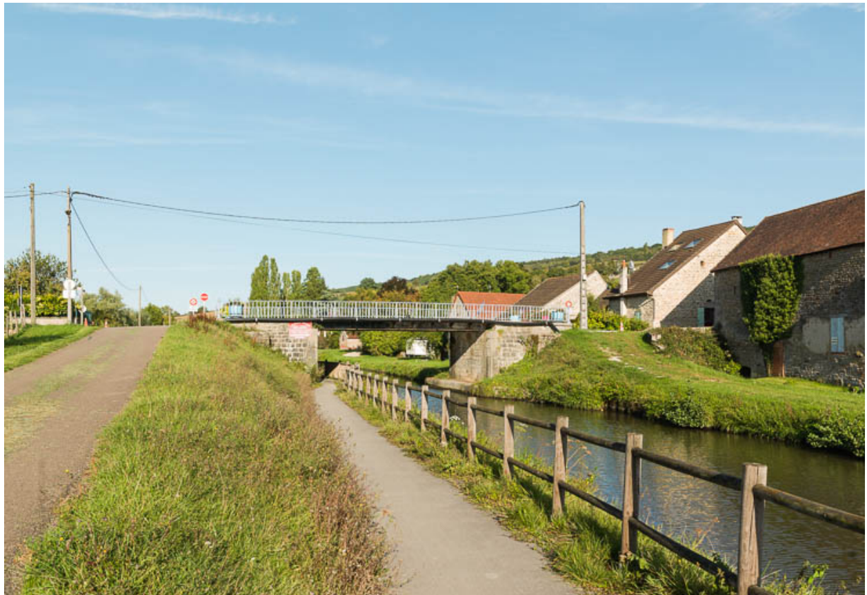
Vue d'ensemble du pont.
