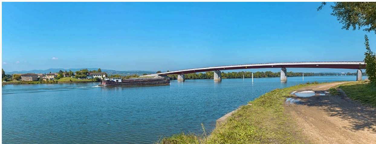
Vue d'ensemble du port et du pont d'Arciat, depuis la rive gauche de la Saône.
