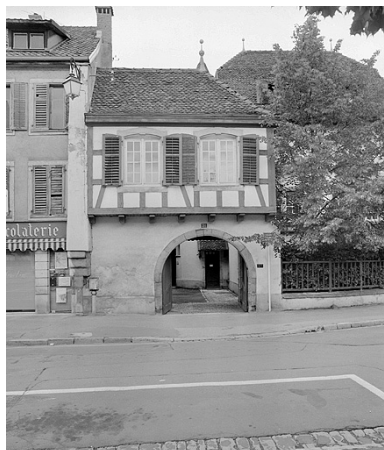
Pavillon d'entrée. Phot. Jérôme Mongreville IVR43_19872500301X
