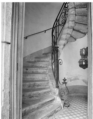
Escalier. Phot. Jérôme Mongreville IVR43_19872500472X
