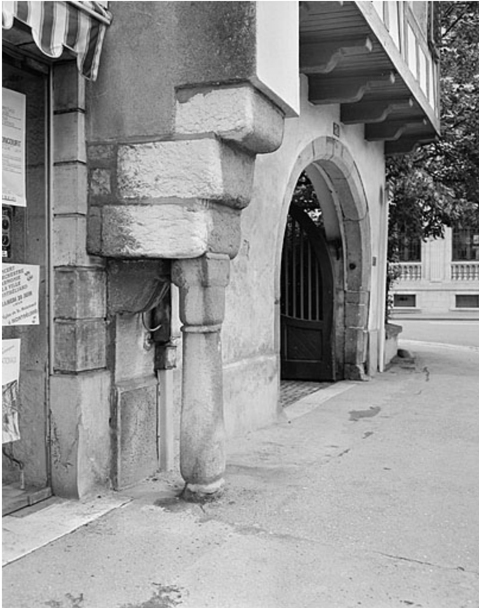
Vestige d'une ancienne maison à surplomb sur lequel s'accrole le corps d'entrée.
