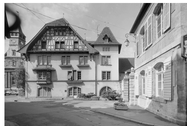
Façade sur la rue du Général-Leclerc. Phot. Jérôme Mongreville IVR43_19882500099V
