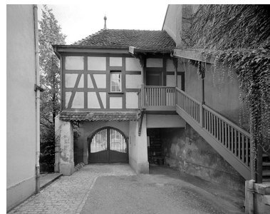
Pavillon d'entrée vu de la cour. Phot. Jérôme Mongreville IVR43_19872501110V
