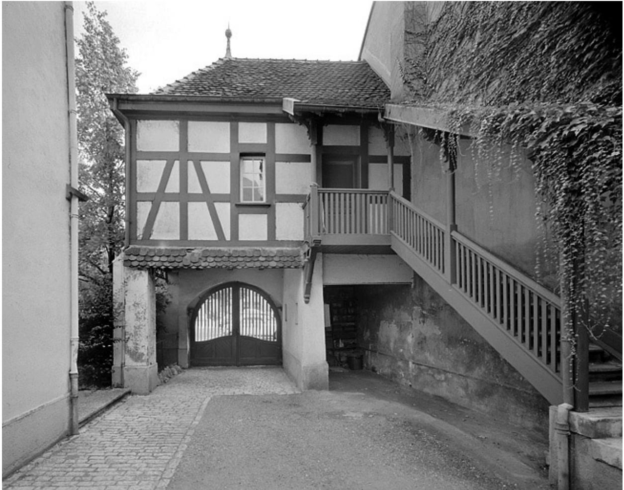
Pavillon d'entrée vu de la cour.
