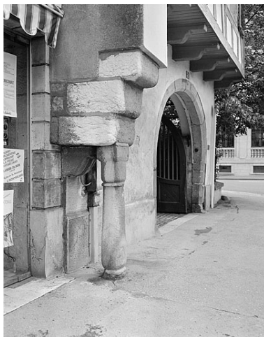
Vestige d'une ancienne maison à surplomb sur lequel s'accrole le corps d'entrée. Phot. Jérôme Mongreville IVR43_19872500302X
