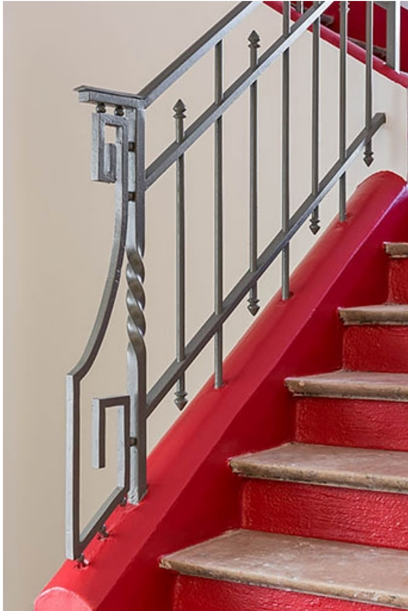
Vestibule : grille de l'escalier.
