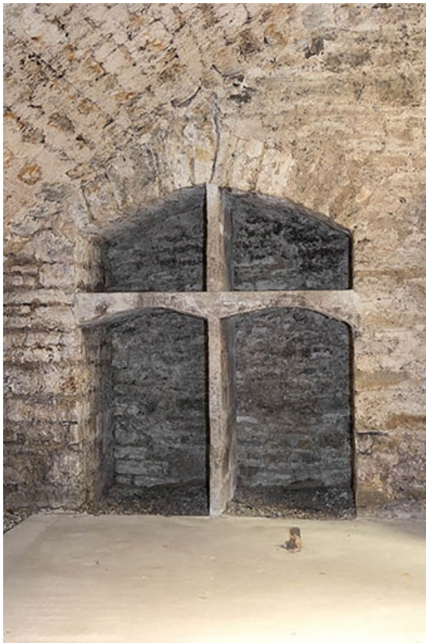
Cave : placard ménagé dans le mur.
