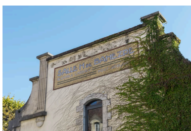
Façade antérieure, de trois quarts droite : partie supérieure avec inscription. Phot. Pierre-Marie Barbe-Richaud IVR26_20212100273NUC4A
