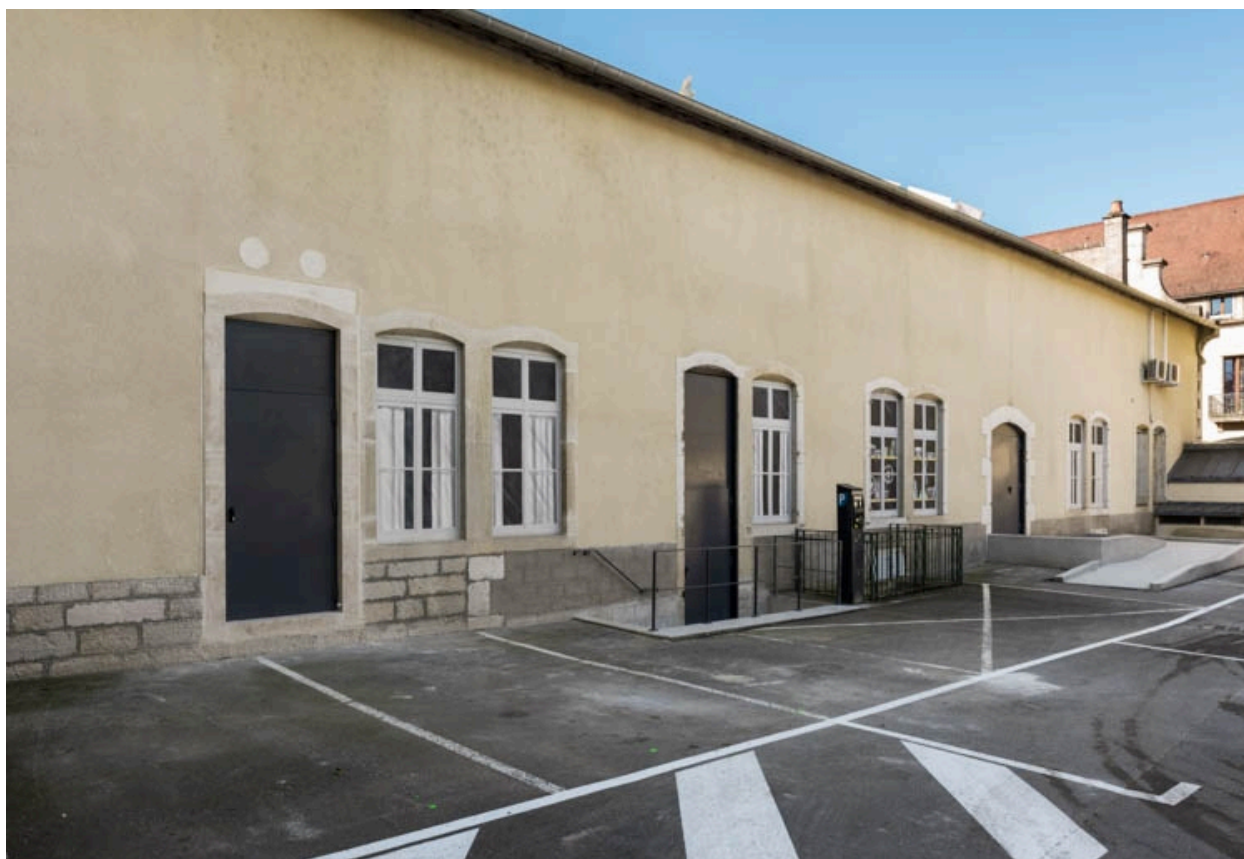
Façade latérale gauche, de trois quarts.
