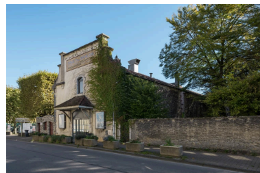
Vue d'ensemble, depuis le sud. Phot. Pierre-Marie Barbe-Richaud IVR26_20212100274NUC4A
