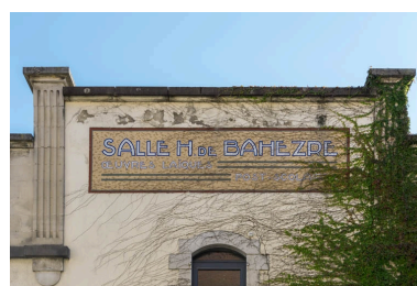
Façade antérieure : l'inscription en mosaïque. Phot. Pierre-Marie Barbe-Richaud IVR26_20212100272NUC2A
