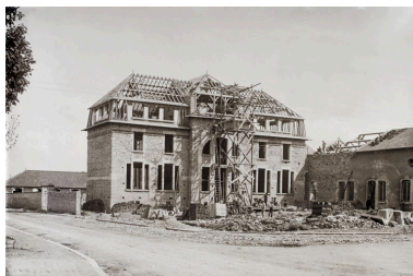
Nuits-Saint-Georges : construction de l'école des garçons. S.d. [entre 1926 et 1930]. A droite est visible l'extrémité du bâtiment, en cours d'extension.
