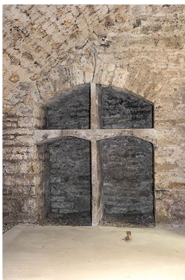
Cave : placard ménagé dans le mur. Phot. Pierre-Marie Barbe-Richaud IVR26_20212100265NUC4A
