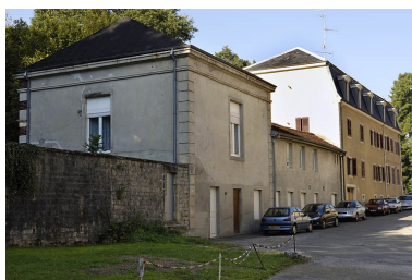
Salle de concert et logement patronal. Phot. Jérôme Mongreville IVR43_20057000505NUCA
