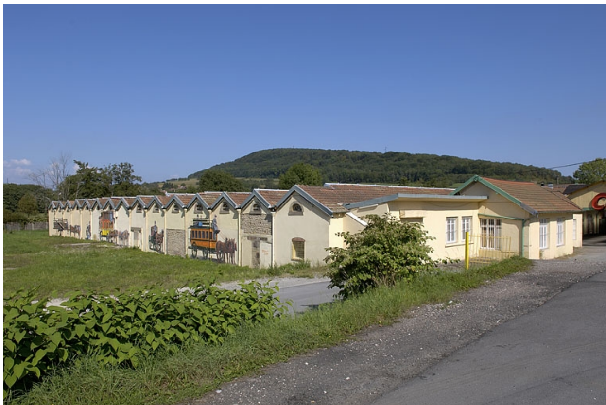
Atelier de fabrication (salle de tissage).
