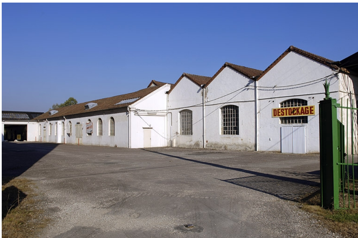
Façades sud de l'atelier de bobinage.
