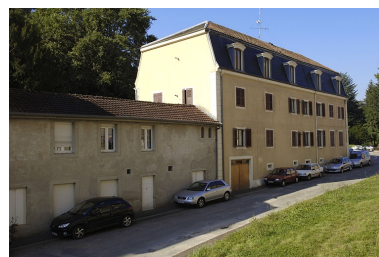
Ancien logement patronal. Phot. Jérôme Mongreville IVR43_20057000504NUCA
