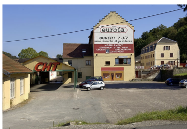
Ateliers de fabrication depuis l'ouest. Phot. Jérôme Mongreville IVR43_20057000511NUCA
