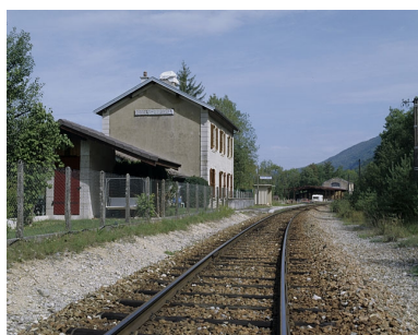
Gare de Dortan - Lavancia (voie fermée Andelot - La Cluse). Phot. Yves Sancey IVR43_20043900515XA
