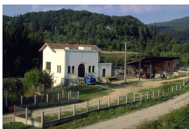
Centrale hydroélectrique située au lieu-dit A la Louve. Phot. Laurent Poupard IVR43_19903900468ZA
