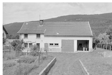
Ferme rue d'Epercy. Phot. Jérôme Mongreville IVR43_19973900890X
