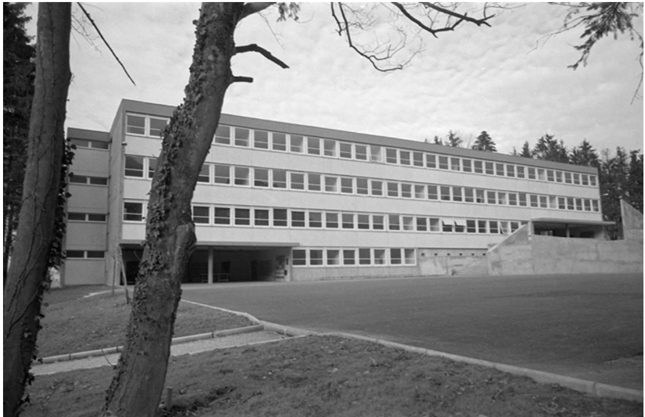
Façade antérieure de l'externat, s.d. [vers 1965].
