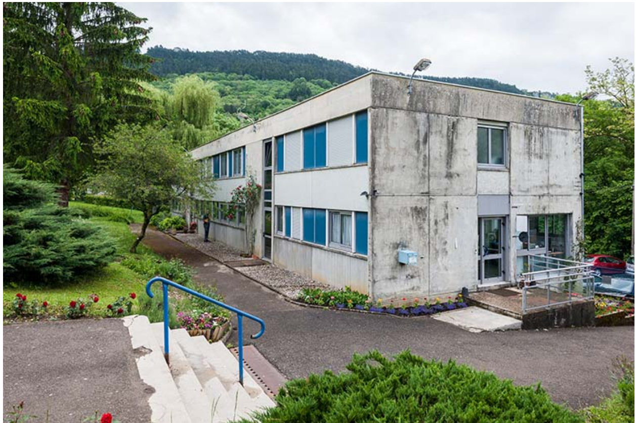
Angle nord-ouest de l'administration.
