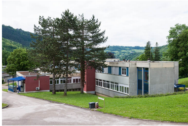
Façade postérieure orientale de la restauration. Phot. Jérôme Mongreville IVR43_20143900056NUC4A
