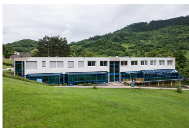
Façade antérieure occidentale de la restauration.
