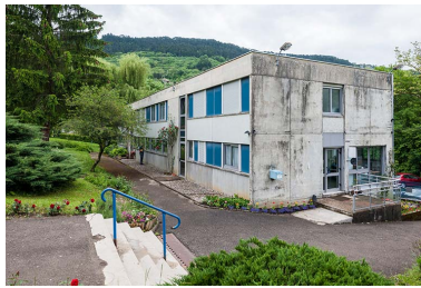
Angle nord-ouest de l'administration. Phot. Jérôme Mongreville IVR43_20143900058NUC4A
