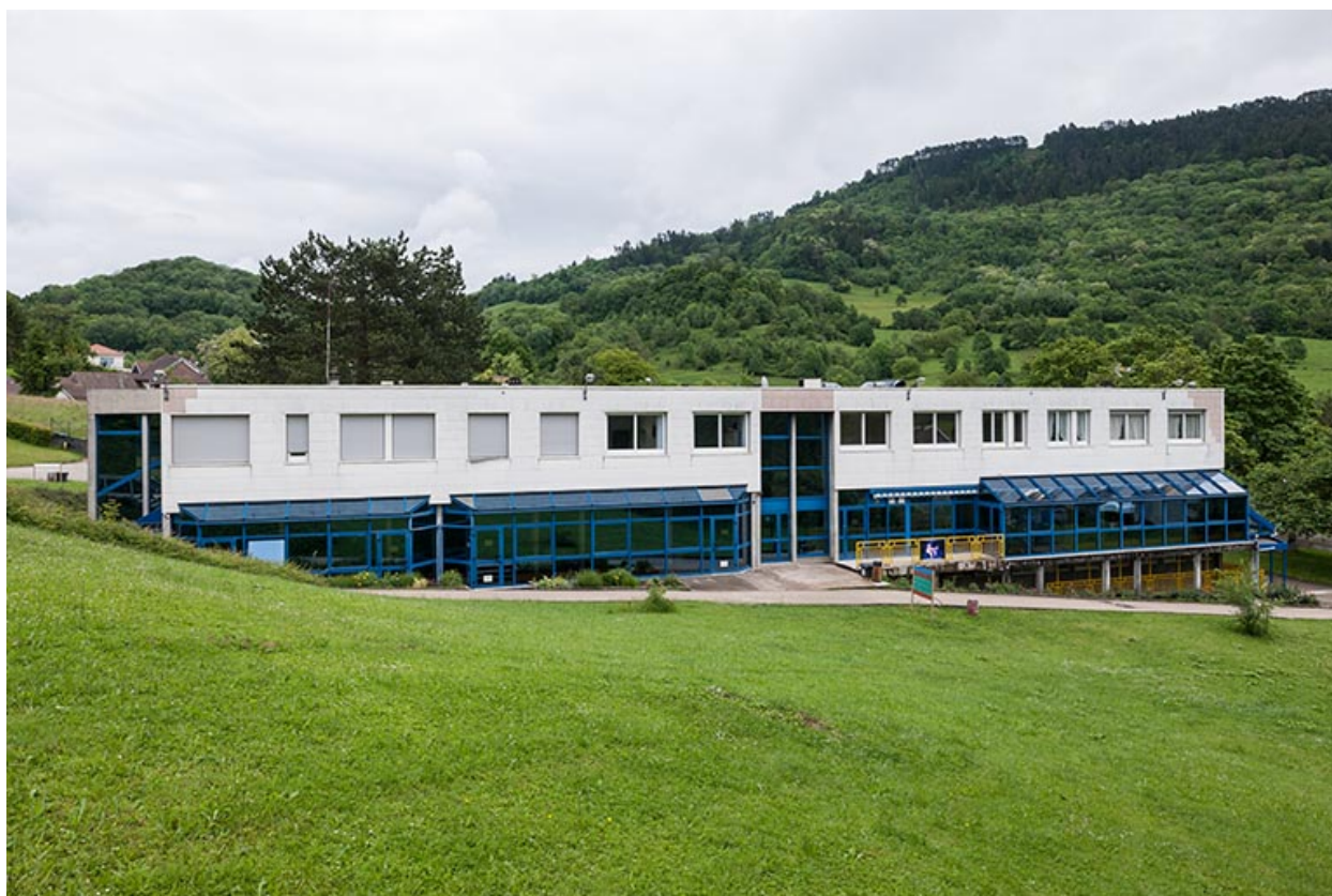
Façade antérieure occidentale de la restauration.
