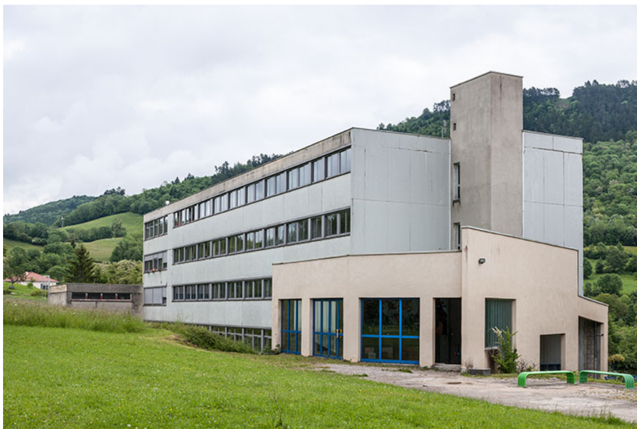
Angle nord-ouest de l'internat de filles.
