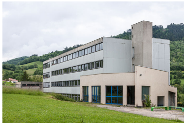
Angle nord-ouest de l'internat de filles. Phot. Jérôme Mongreville IVR43_20143900069NUC4A
