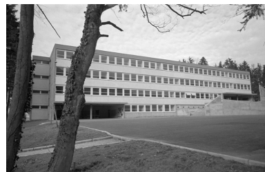
Façade antérieure de l'externat, s.d. [vers 1965].
