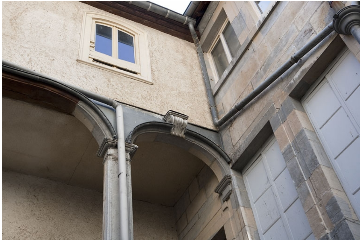
Escalier à cage ouverte sur cour : détail des arcs soutenant la galerie, partie droite.
