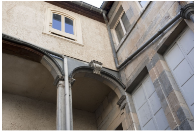
Escalier à cage ouverte sur cour : détail des arcs soutenant la galerie, partie droite. Phot. Yves Sancey IVR43_20112500995NUC2A
