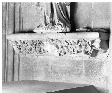
Grande console occidentale : vue d'ensemble.
