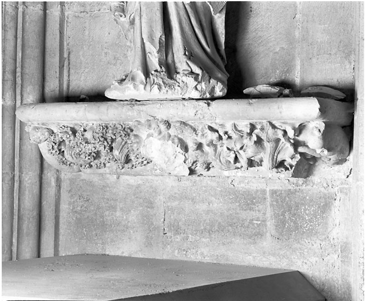
Grande console occidentale : vue d'ensemble.
