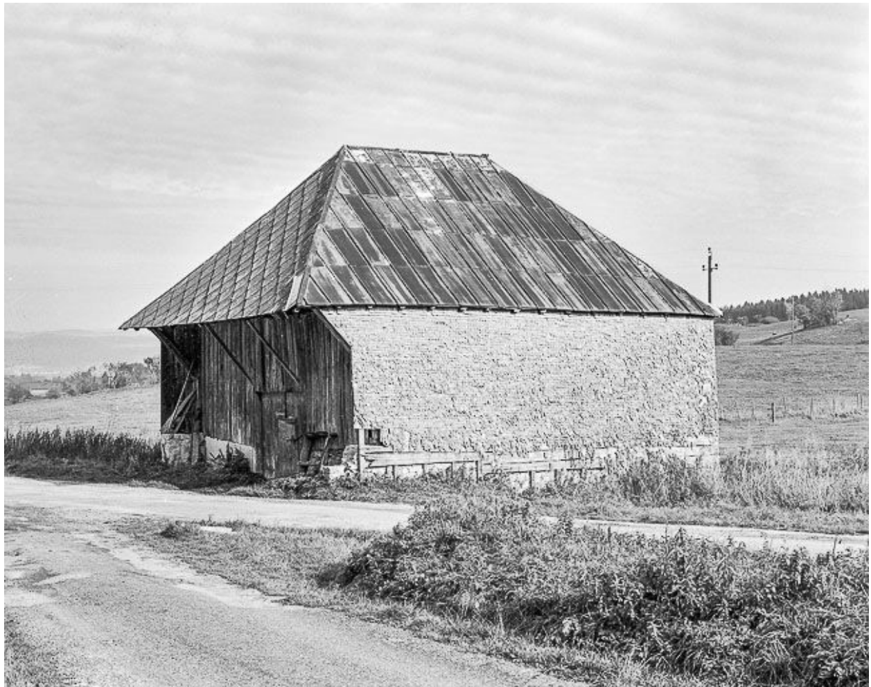
Bâtiment servant de remise.
