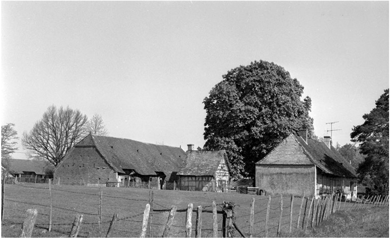
Vue d'ensemble depuis le sud en 1975.
