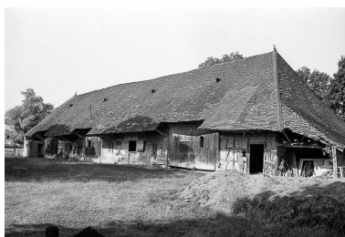
Façade postérieure en 1975. Phot. Guy Forestier IVR43_19753900081Z
