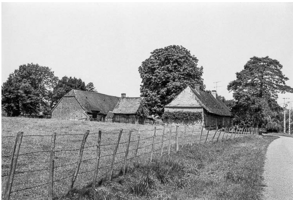
Vue d'ensemble depuis le sud en 1975.
