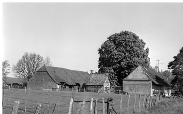
Vue d'ensemble depuis le sud en 1975. Phot. Bernard Lardière IVR43_19793900309X
