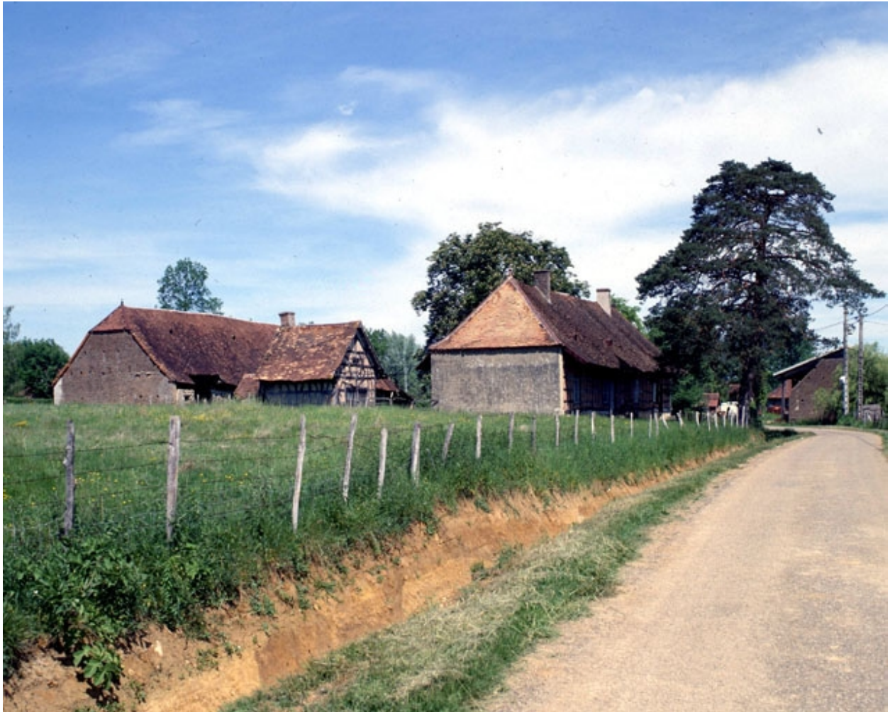
Vue d'ensemble depuis le sud en 1990.
