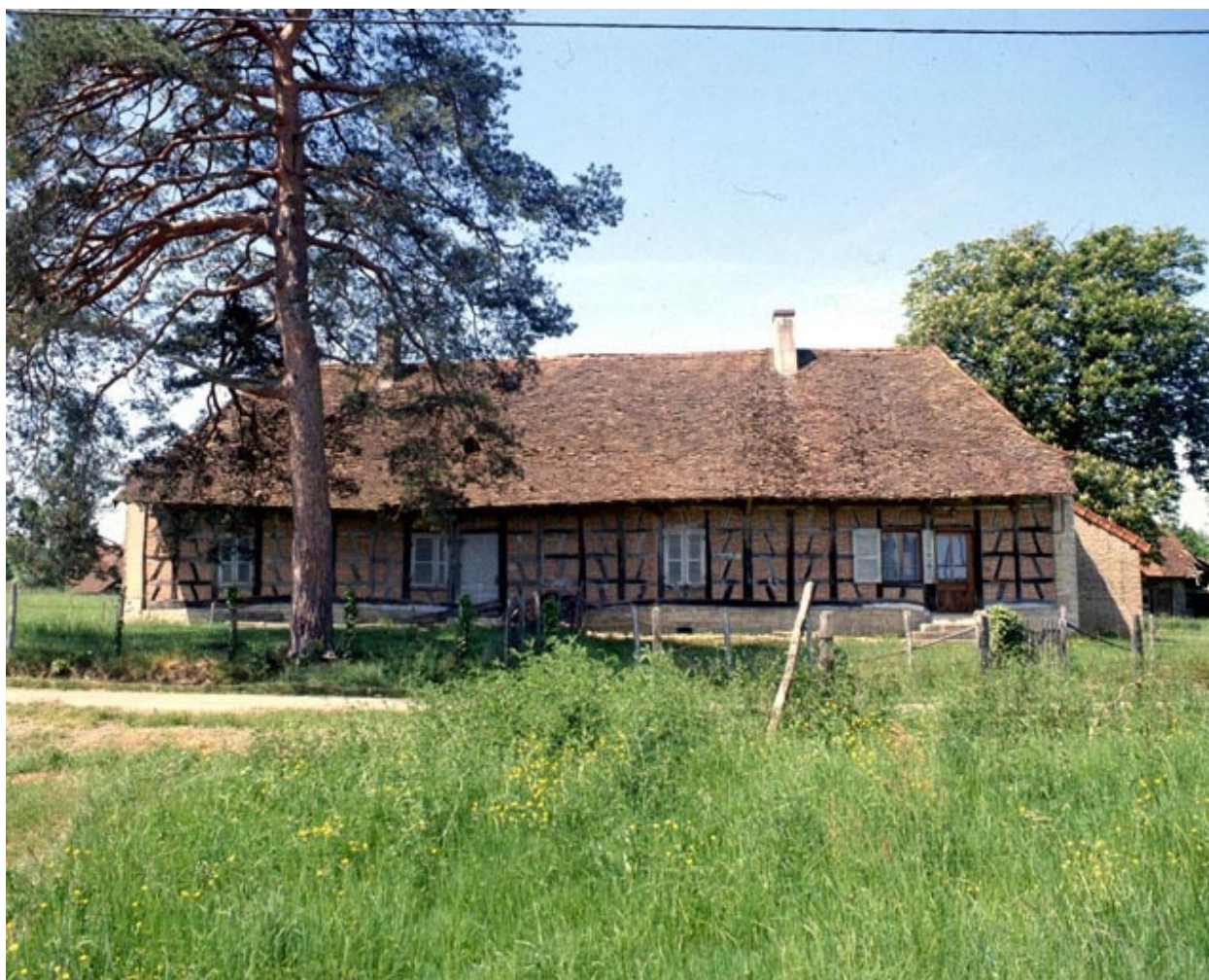
Bâtiment d'habitation vu de face en 1990.
