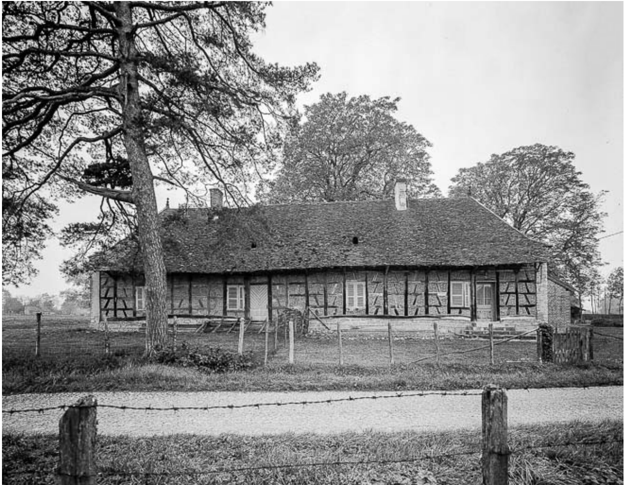
Bâtiment d'habitation vu de face en 1975.
