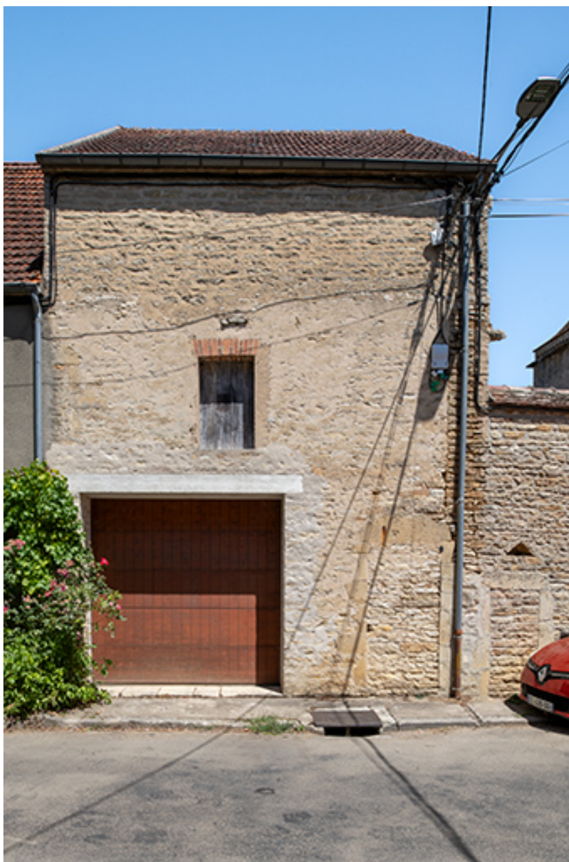
Façade d'une ancienne grange-étable sur rue.
