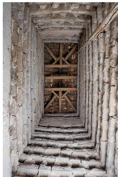
Le quatrième niveau du colombier, de l'intérieur. Phot. Nicolas Waltefaugle IVR26_20268900236NUC4A
