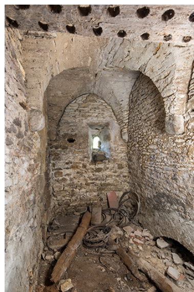
Le premier niveau du colombier, en direction de la Cure. Phot. Nicolas Waltefaugle IVR26_20268900245NUC4A
