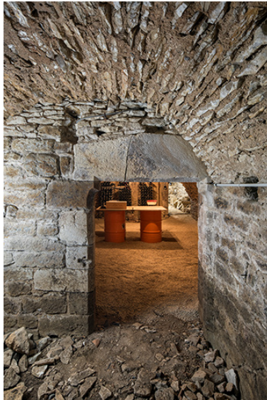
L'entrée de la cave située sous la terrasse. Phot. Nicolas Waltefaugle IVR26_20268900246NUC4A
