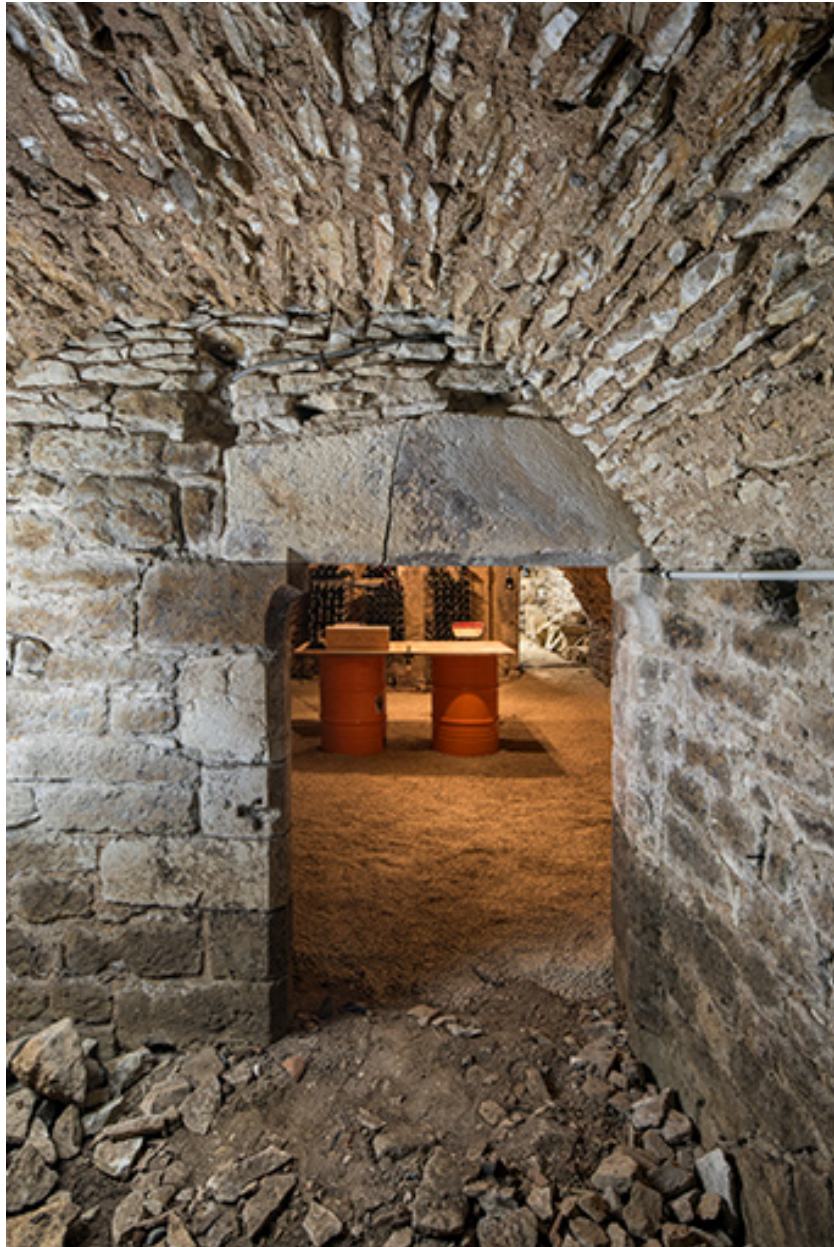
L'entrée de la cave située sous la terrasse.
