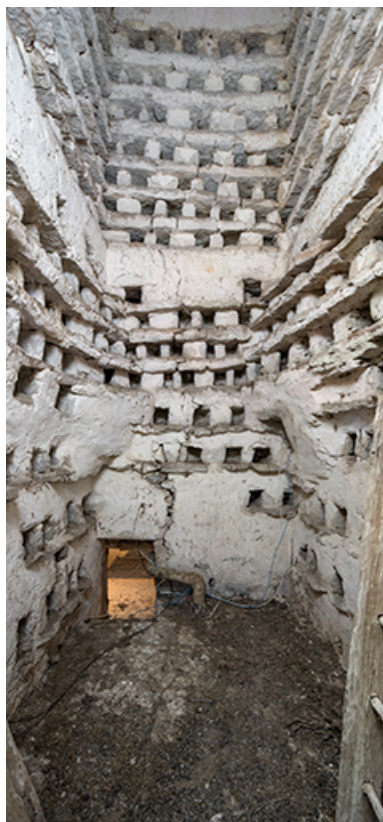
Le quatrième niveau du colombier, de l'intérieur. Phot. Nicolas Waltefaugle IVR26_20268900238NUC4A
