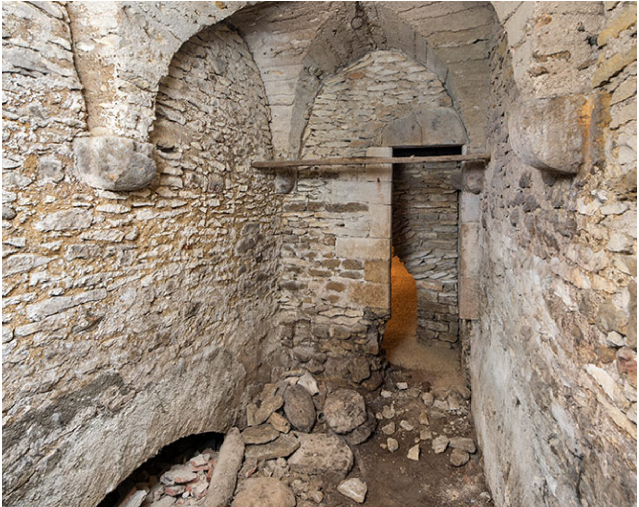
Le premier niveau du colombier, en direction des autres caves.
