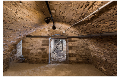
La cave située sous la demeure. Phot. Nicolas Waltefaugle IVR26_20268900247NUC4A
