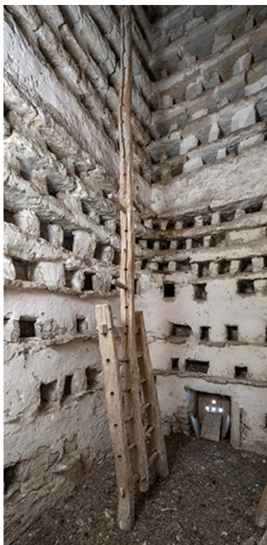
Le quatrième niveau du colombier, de l'intérieur. Phot. Nicolas Waltefaugle IVR26_20268900237NUC4A
