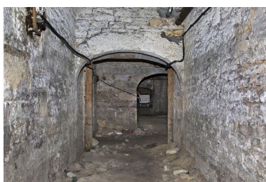
Sous-sol : détail d'un passage.
