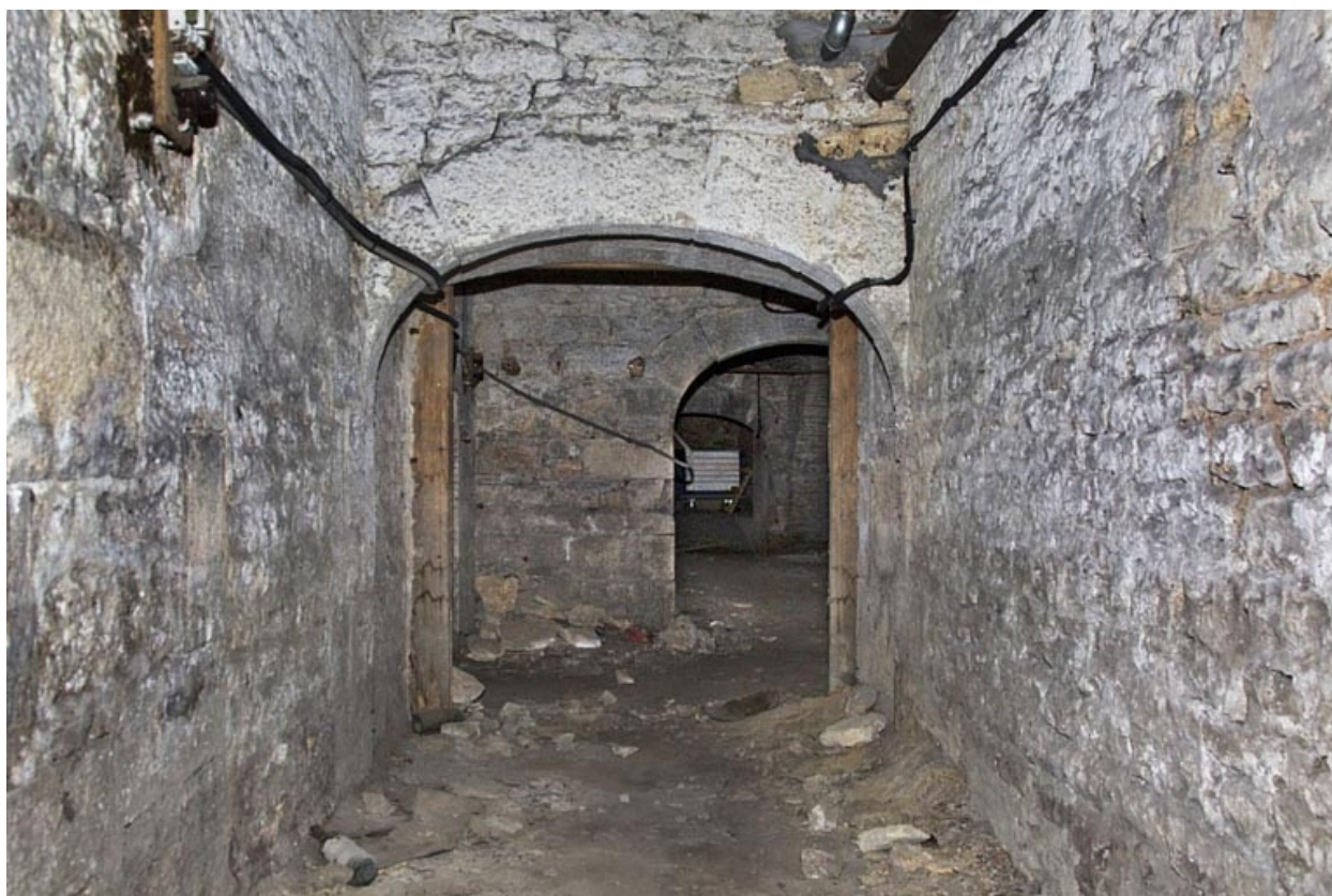
Sous-sol : détail d'un passage.
