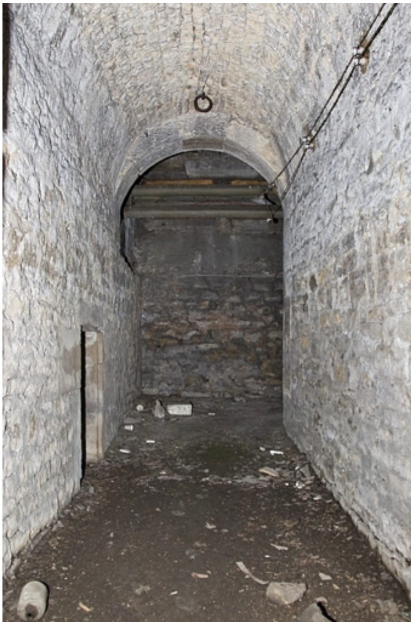
Sous-sol : détail d'un couloir voûté en berceau.
