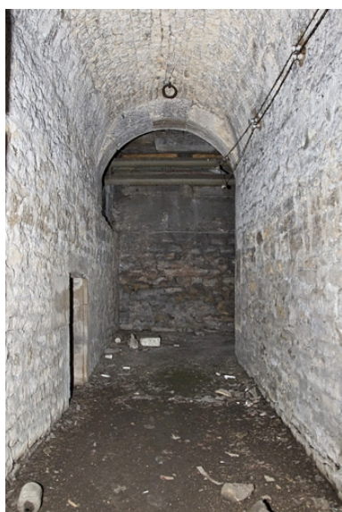
Sous-sol : détail d'un couloir voûté en berceau.
