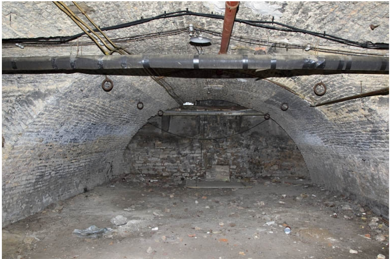
Sous-sol : détail d'une cave voûtée en berceau.
