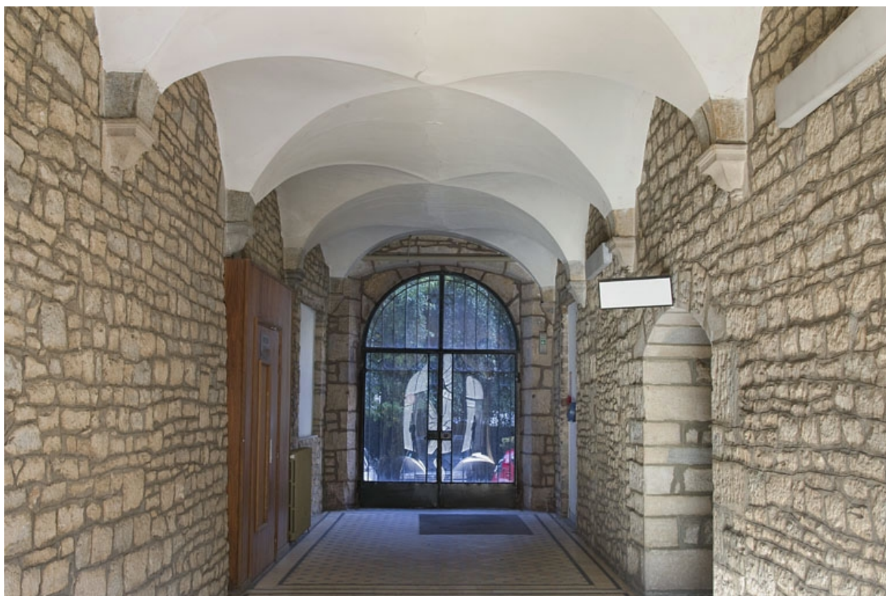
Intérieur : vue d'ensemble du couloir depuis l'entrée.
