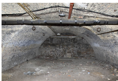
Sous-sol : détail d'une cave voûtée en berceau.
