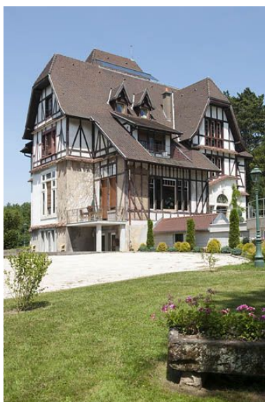
Façades ouest et sud. Phot. Jérôme Mongreville IVR43_20112501255NUC4A
