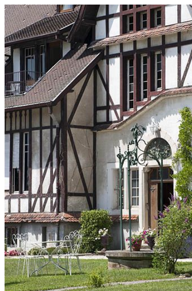
Façade sud vue de trois quarts. Phot. Jérôme Mongreville IVR43_20112501250NUC4A
