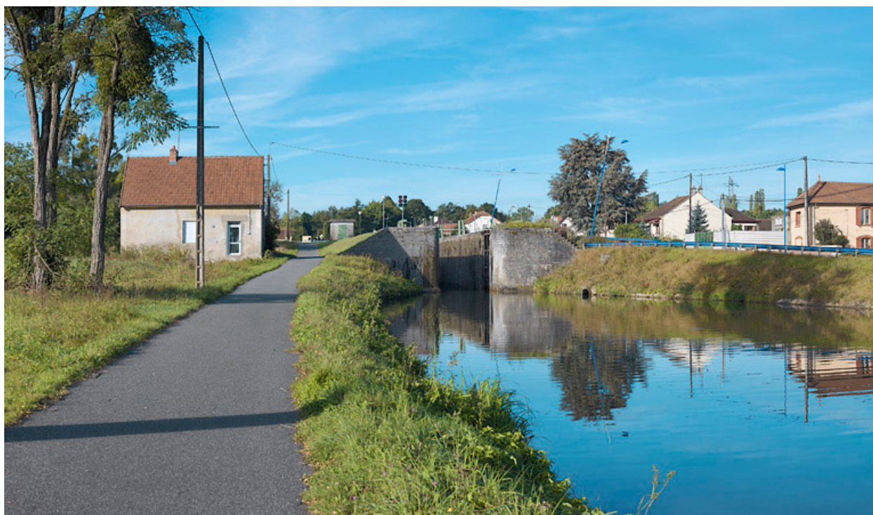
Site de l'écluse 02 depuis le bief 03.
