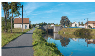
Site de l'écluse 02 depuis le bief 03. Phot. Thierry Kuntz IVR26_20127100414NUC4A
