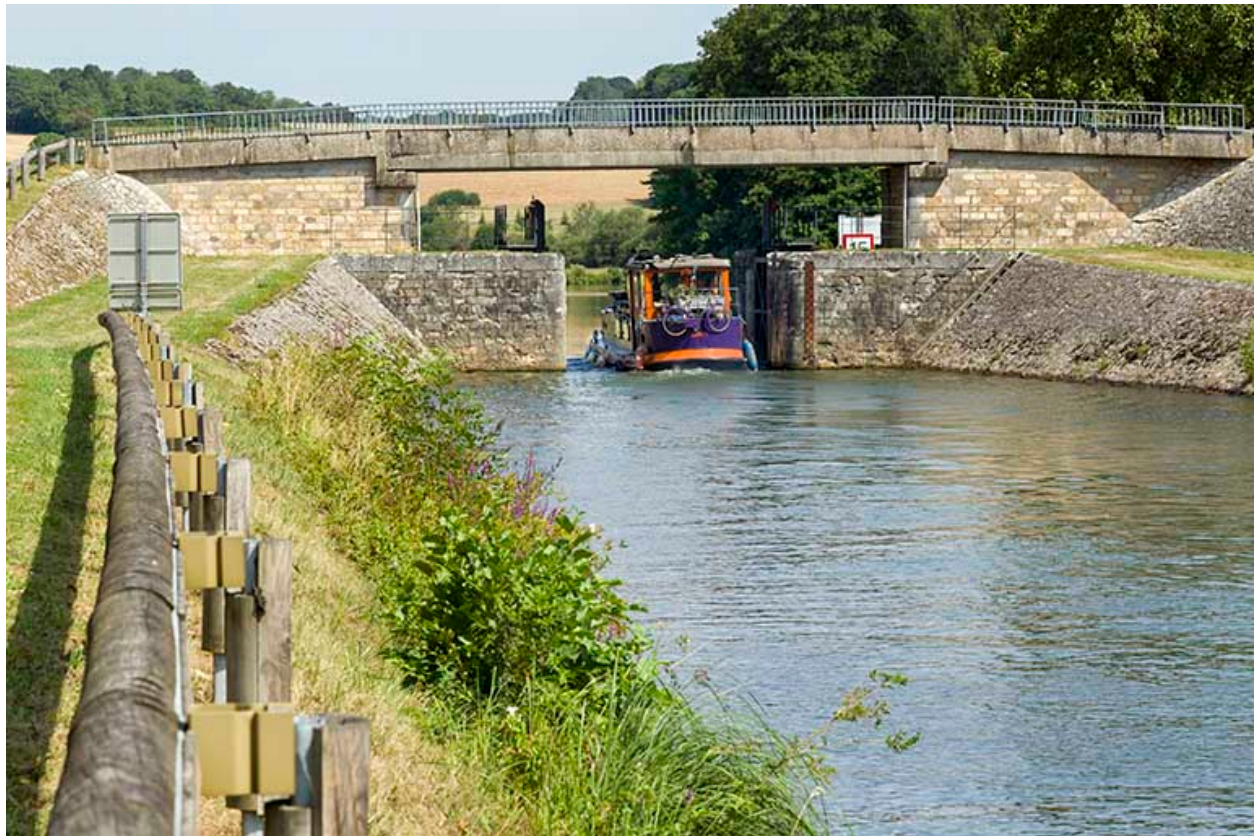
Vue aval de la porte de garde.
