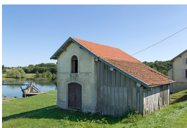
Magasin à aiguilles du barrage. Phot. Sonia Dourlot IVR43_20157001517NUC2A
