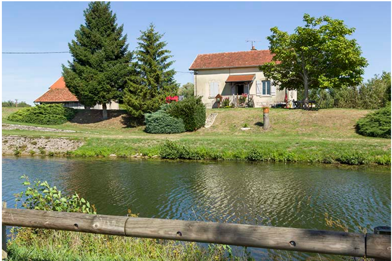
Maison du barragiste.
