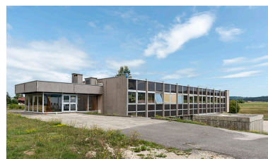
Façades antérieure et latérale gauche.
