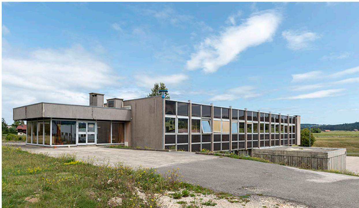
Façades antérieure et latérale gauche.
