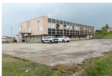
Façades postérieure et latérale droite.
