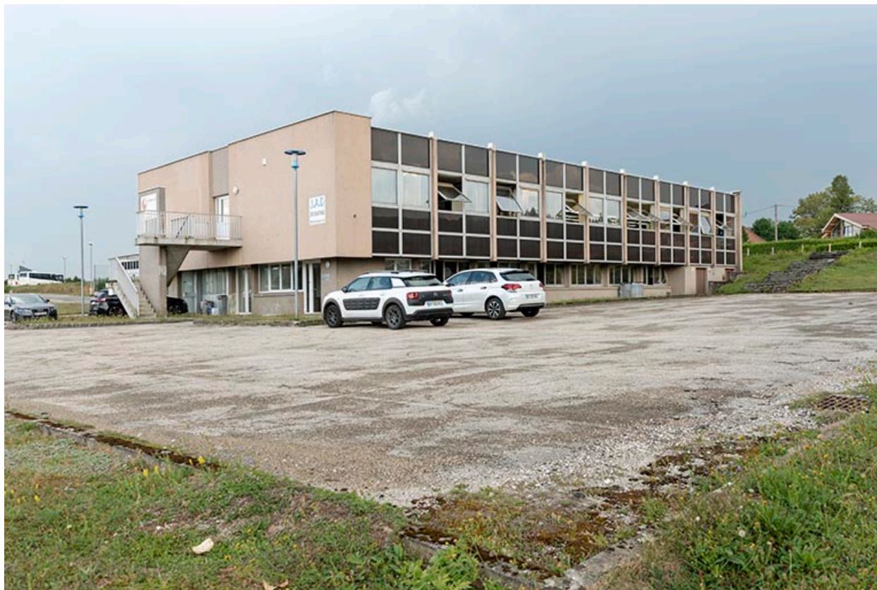
Façades postérieure et latérale droite.
