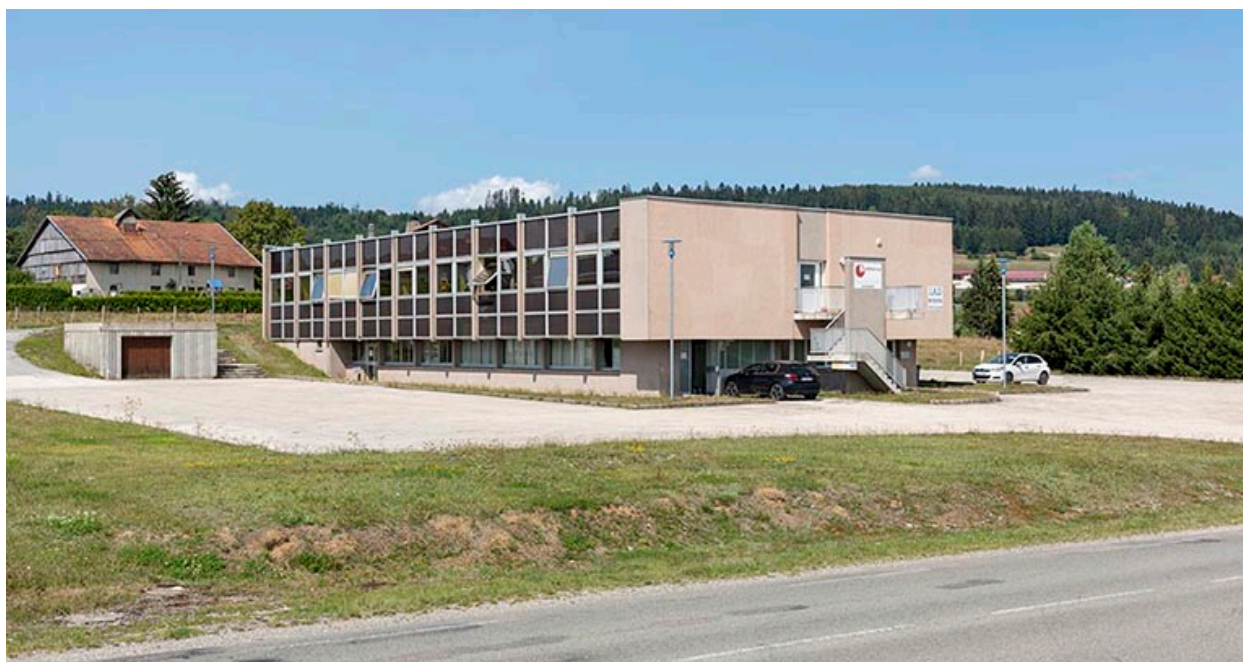
Façades antérieure et latérale droite.
