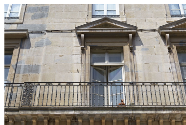
Façade antérieure : détail du balcon.
