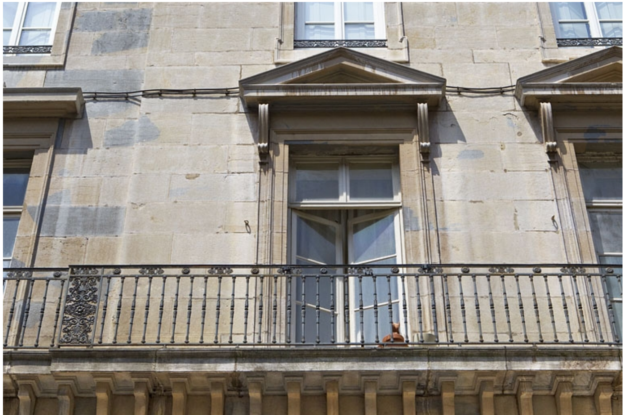
Façade antérieure : détail du balcon.
