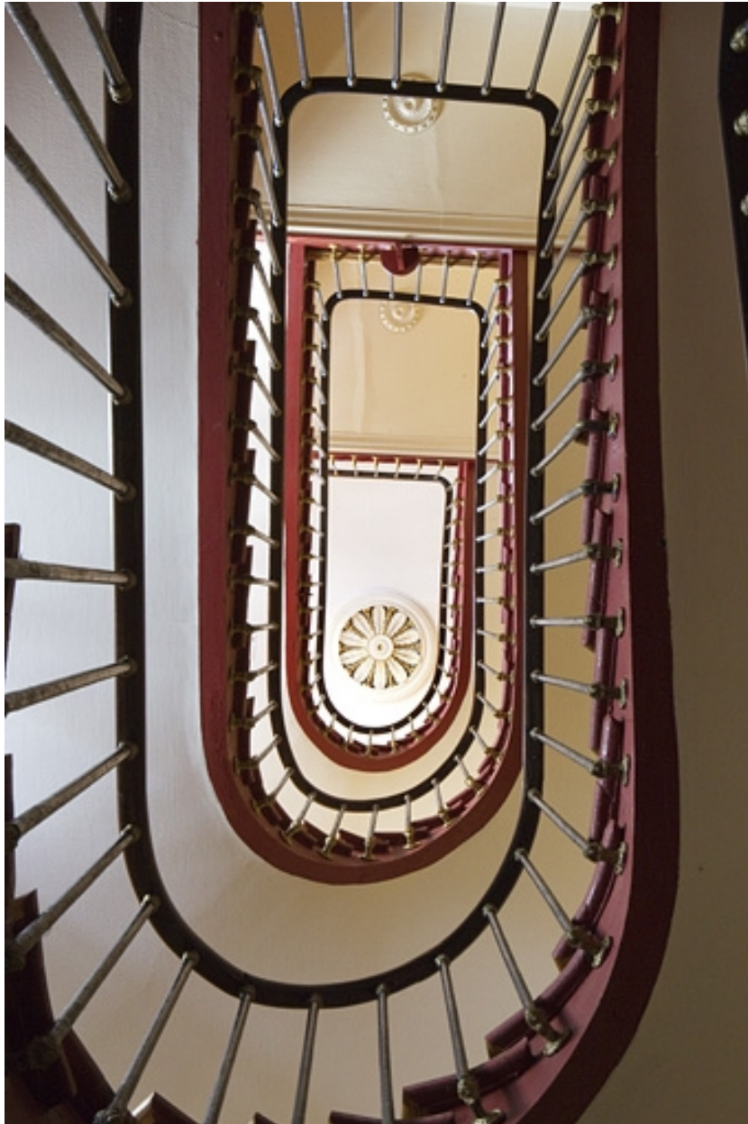
Vue d'ensemble de l'escalier depuis le rez-de-chaussée.
