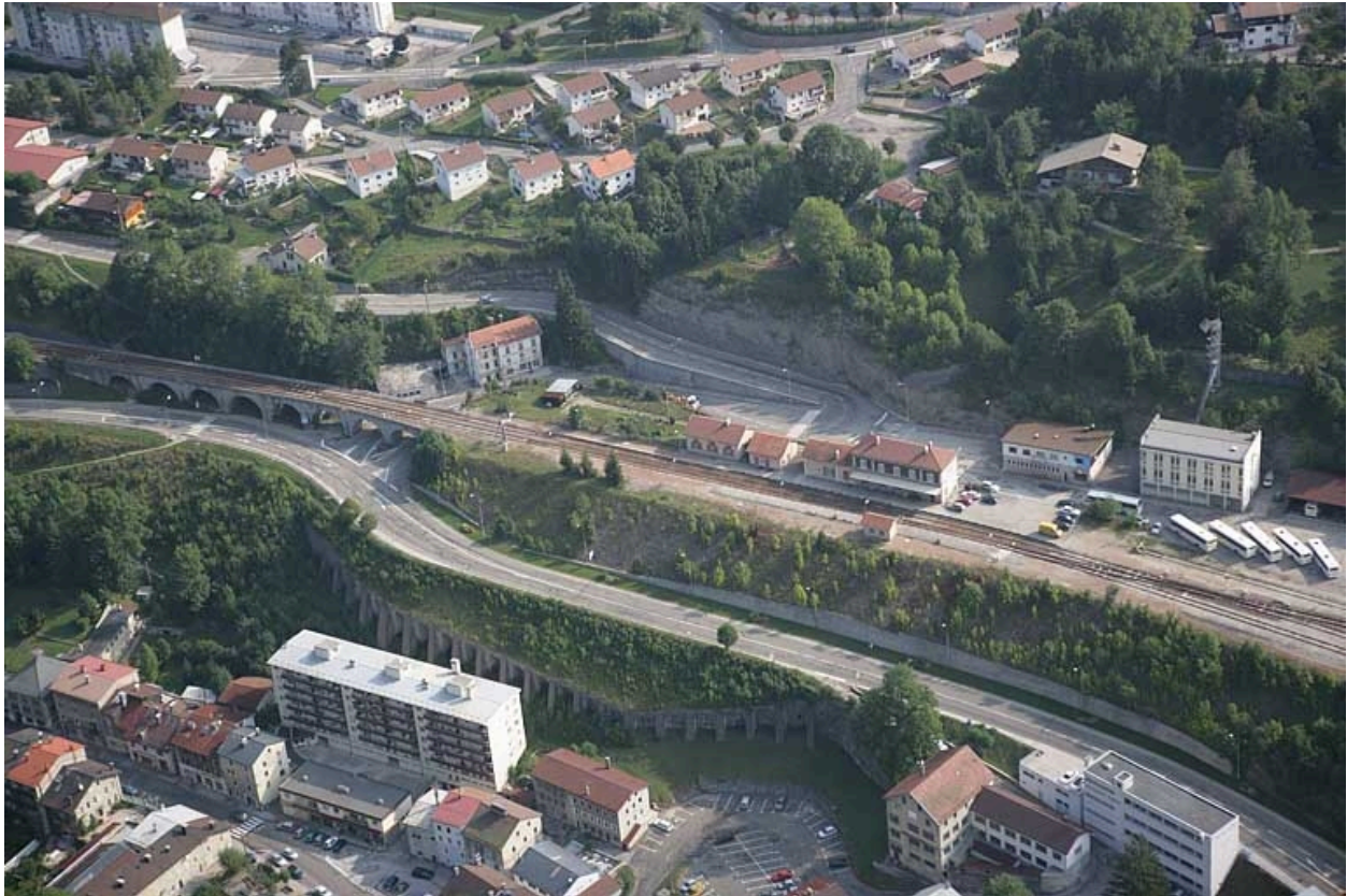
Vue aérienne de la partie supérieure de l'avenue et du mur à arcades, depuis le sud-ouest.
