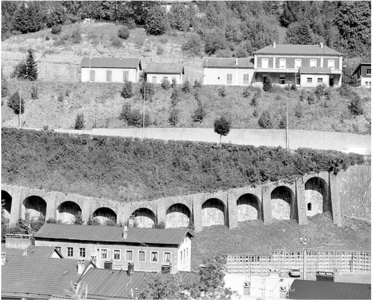
Vue d'ensemble du mur à arcades, depuis l'ouest.
