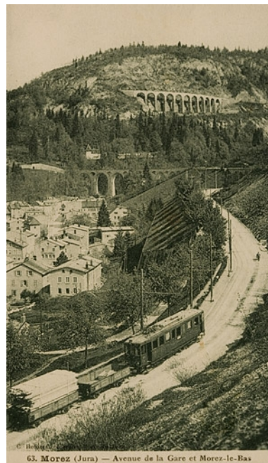
Morez (Jura) - Avenue de la Gare et Morez-le-Bas, 2e quart 20e siècle. Phot. IVR43_20073900014NUCA
