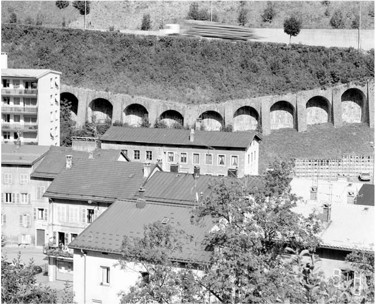
Mur à arcades, depuis l'ouest.
