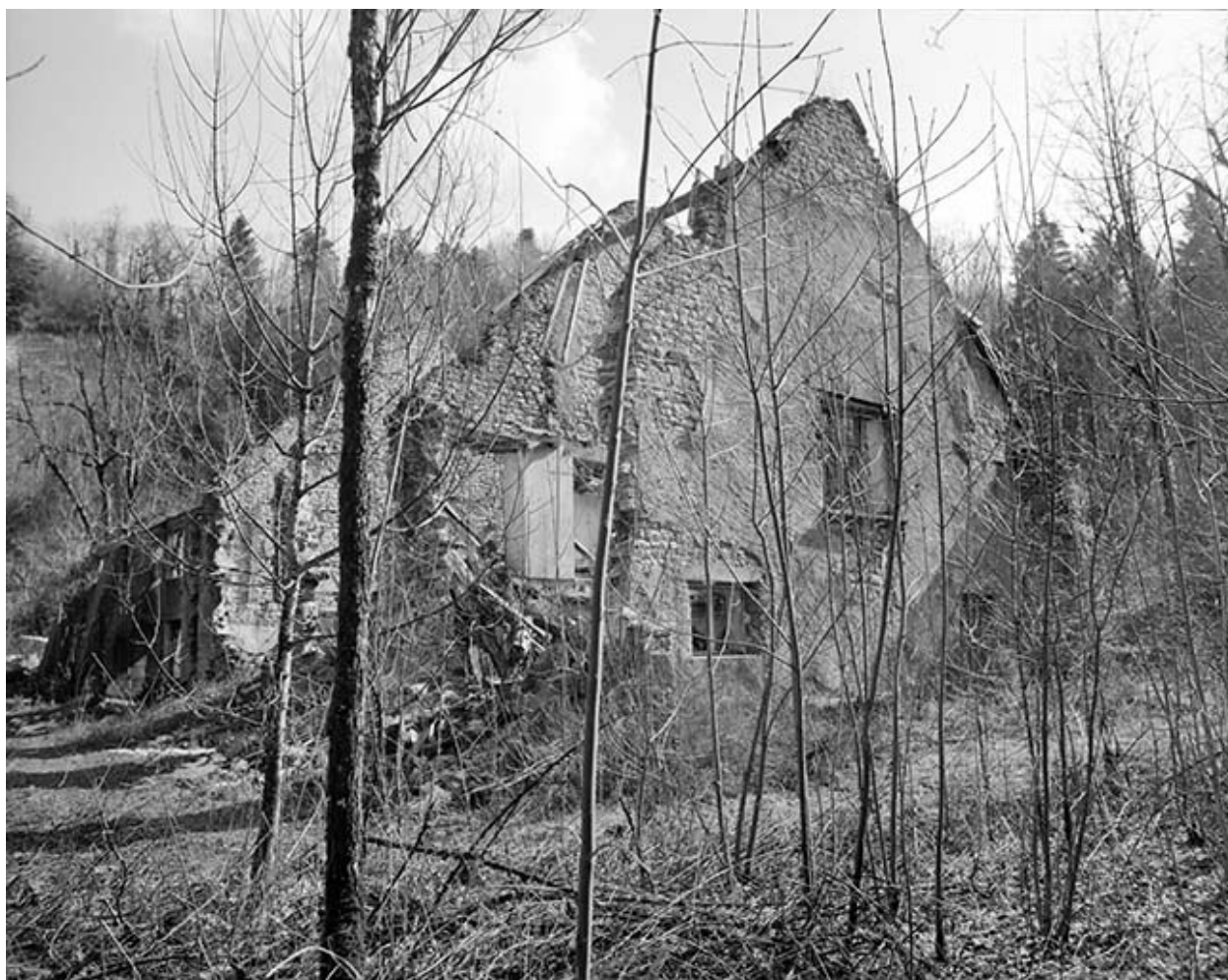
Pignon ouest du logement patronal.
