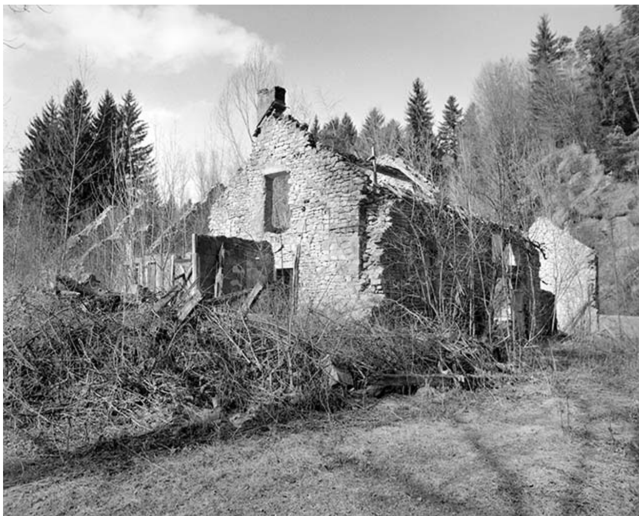
Aile sud du logement patronal.
