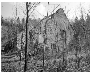
Pignon ouest du logement patronal. Phot. Jérôme Mongreville IVR43_19963900129X
