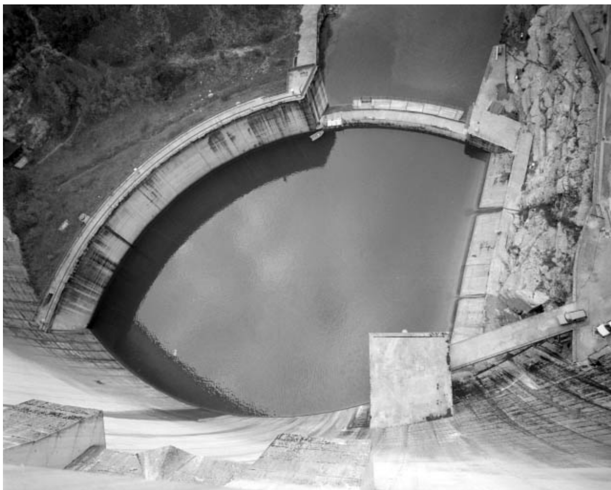
Vue plongeante sur le bassin d'amortissement.
