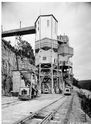
Tour à béton et silobus.
