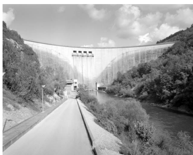
Le barrage, vu d'aval. Phot. Jérôme Mongreville IVR43_19913900670X
