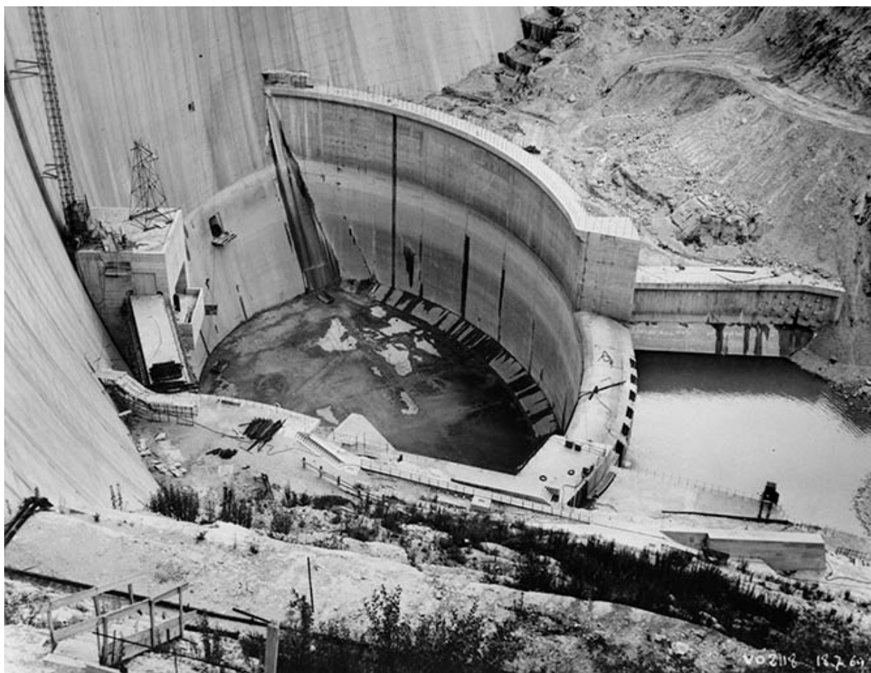
Bassin d'amortissement - Vue générale rive gauche.
