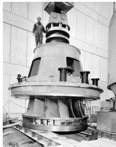
Roue turbine : support pivotier en cours de montage. Phot. Jérôme Mongreville, Autr. Studios Villeurbannais Monchanin et Périchon IVR43_19913900320X
