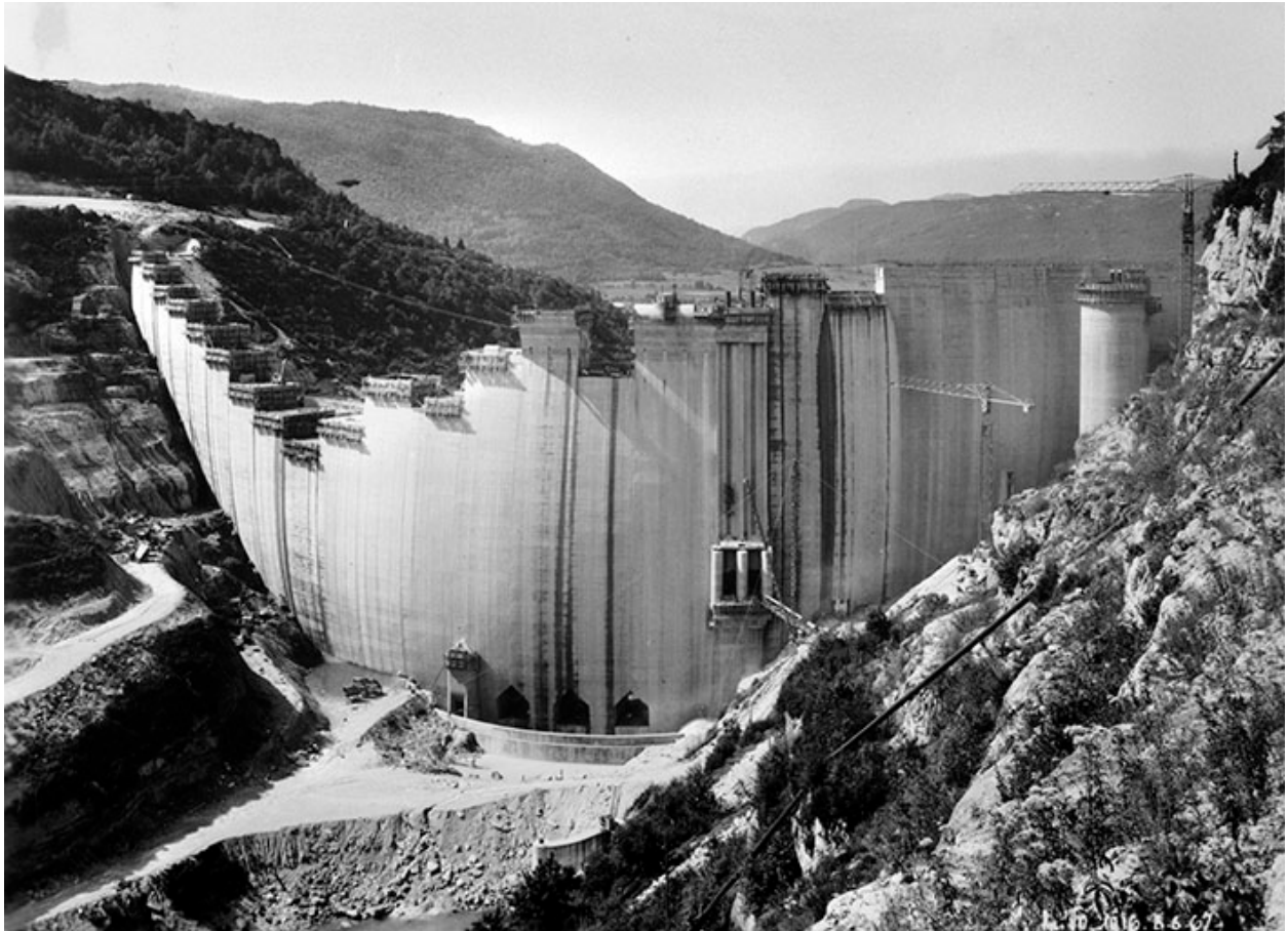
Barrage - Vue générale amont.
