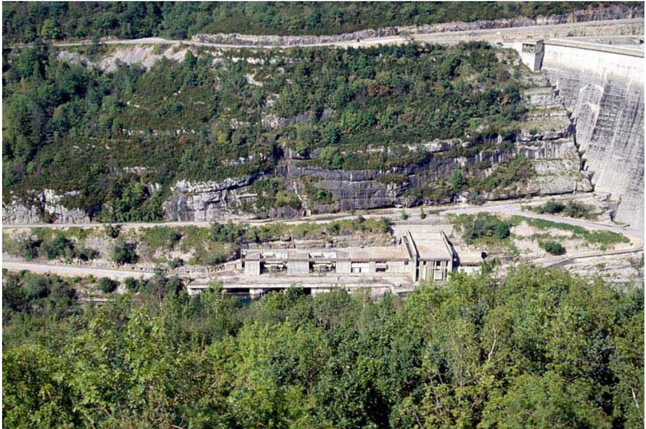
La centrale hydroélectrique.
