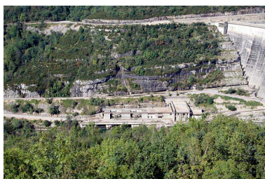
La centrale hydroélectrique. Phot. Jérôme Mongreville IVR43_19913900685ZA
