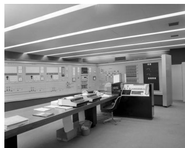
Vue d'ensemble de la salle de commande. Phot. Jérôme Mongreville IVR43_19913900686X
