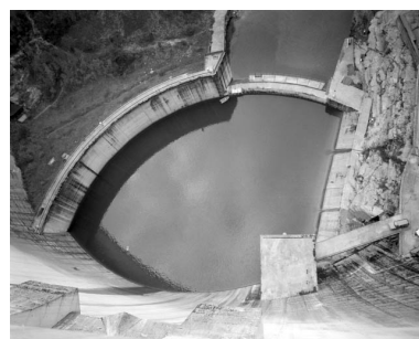
Vue plongeante sur le bassin d'amortissement. Phot. Jérôme Mongreville IVR43_19913900675X
