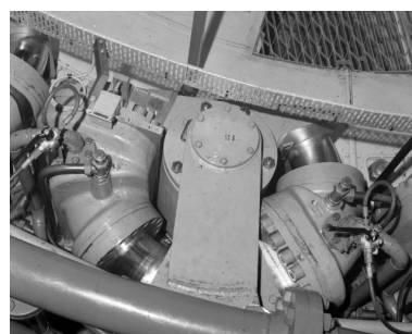
Groupe n° 4 : servo-moteurs toriques actionnant les aubes directrices de la turbine. Phot. Jérôme Mongreville IVR43_19913900696X
