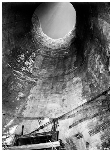
Puits 1-2, sommet entonnement 1.
