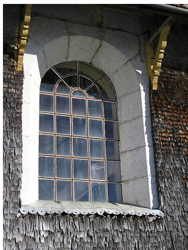
Vue d'une baie. Phot. Marie-Pierre Reynet IVR43_20083900462NUC1A
