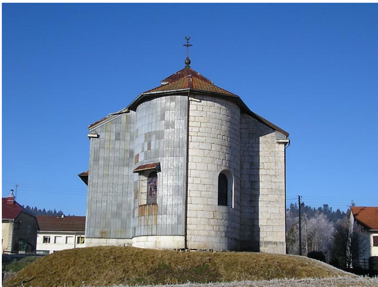
Vue générale de l'abside.
