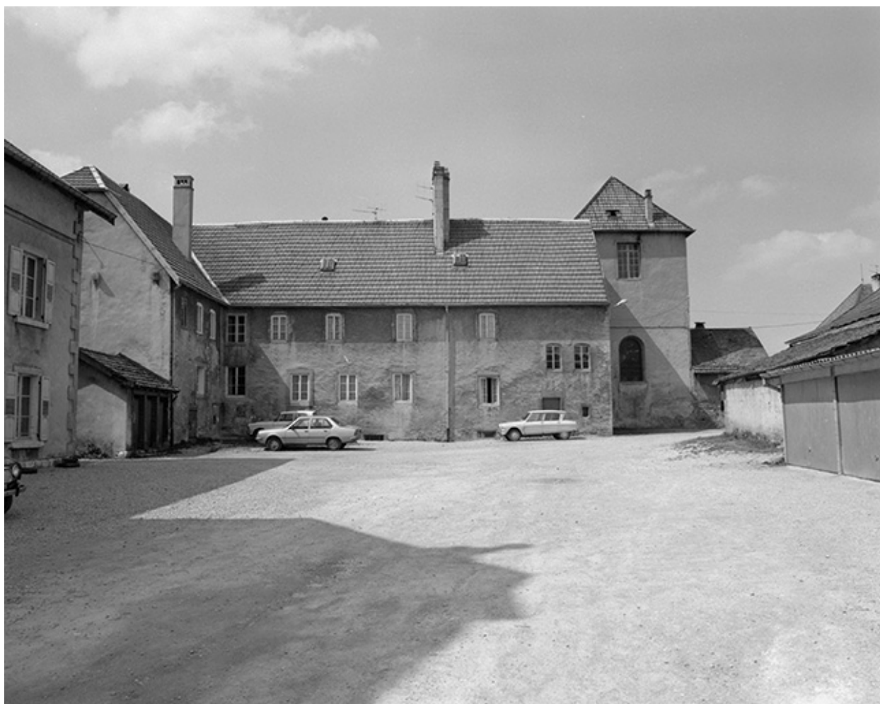
Façade extérieure d'un corps de bâtiment conventuel.
