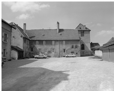
Façade extérieure d'un corps de bâtiment conventuel. Phot. Yves Sancey IVR43_19802500178X
