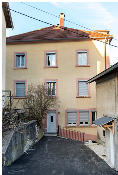
Façade latérale droite. Phot. Sonia Dourlot IVR43_20162501685NUC4A
