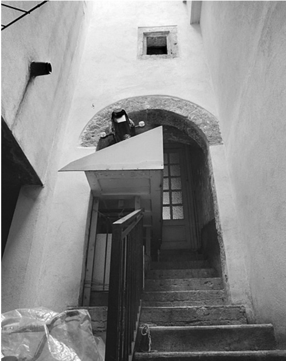
Façade sur cour du corps de bâtiment principal.
